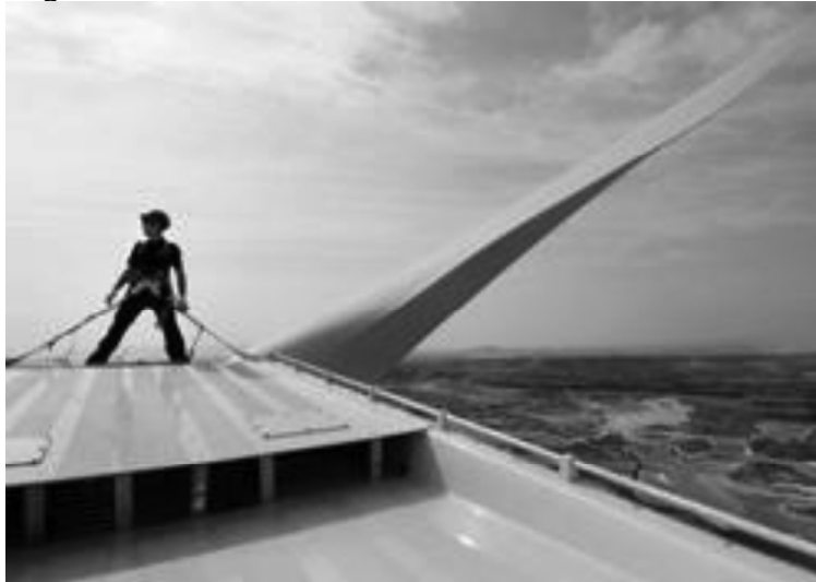
Abbildung 10-2: Arbeiten auf dem Maschinenhaus
