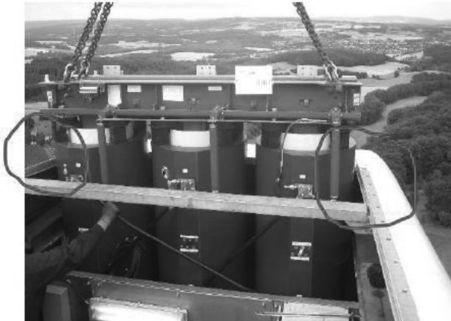
Abbildung 18-1: Führen des Transformators in das Maschinenhaus
