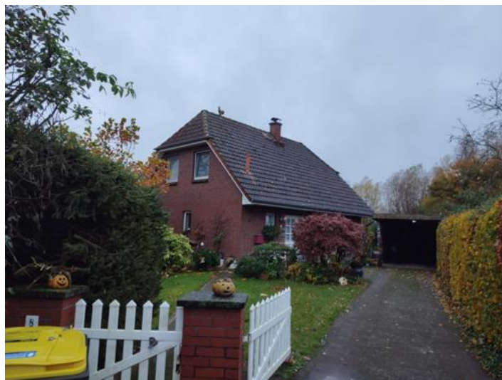
Abbildung 9.5: Nord-Ostansicht IO-03 (Hofweg 8; 19073 Wittenförden)
