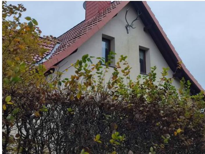
Abbildung 9.2: Süd-Ostansicht IO-01 (Rabenhornstraße 11; 19073 Wittenförden)
