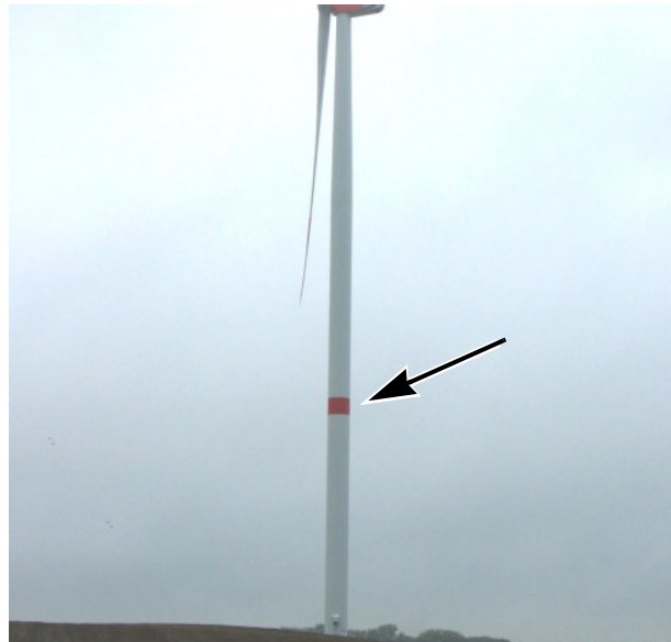
Abb. 4 Roter Farbring an Anlage mit Gesamthöhe >150 m
