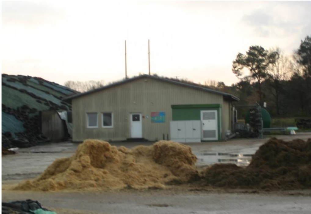
IP AK: Arbeitsraum Biogasanlage Süd Hof Karp, Eichenweg 1, Kraak
