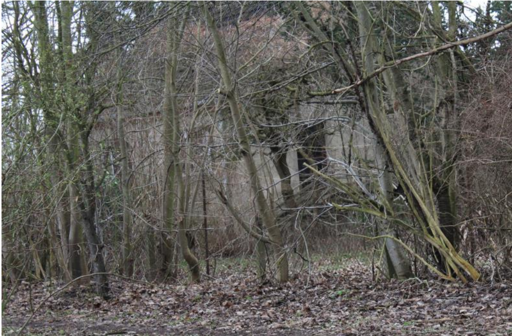
IP EN: Whs. Greifswalder Str.6a, Karlsburg
