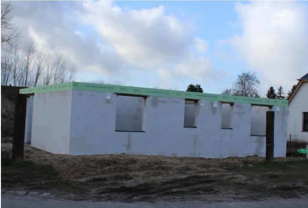
IP HB: Rohbau Dorfstr. 15+16, Moeckow
