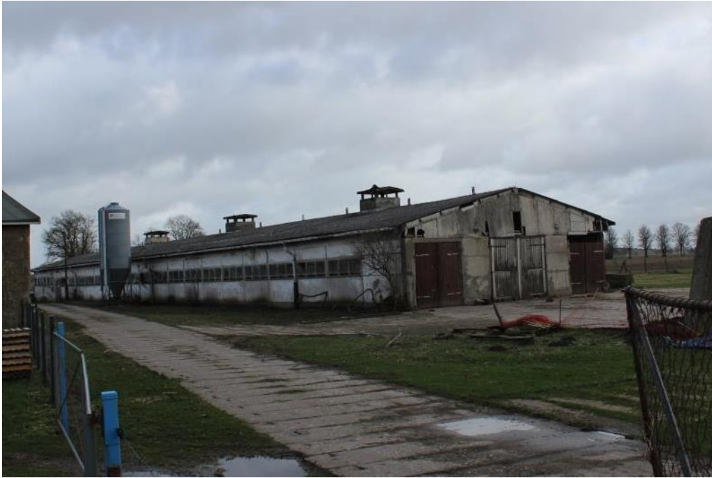
IP EL: Halle Greifswalder Str., Karlsburg
