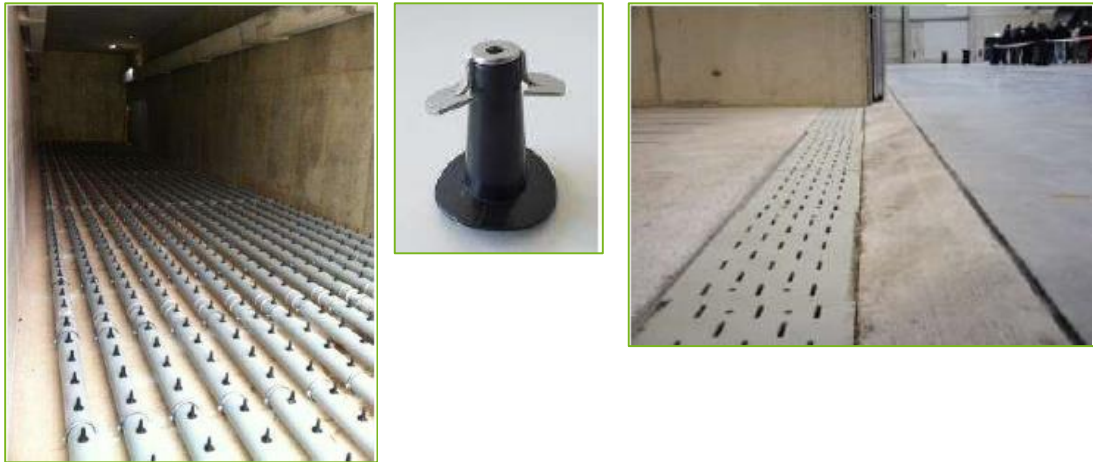
Abb. 5: Spigotboden vor Betonage (l.), Spigotdüse (Mitte), Entwässerungsrinne an Tunnelvorderseite (r.) [Quelle: Eggersmann Anlagenbau Concept GmbH]
