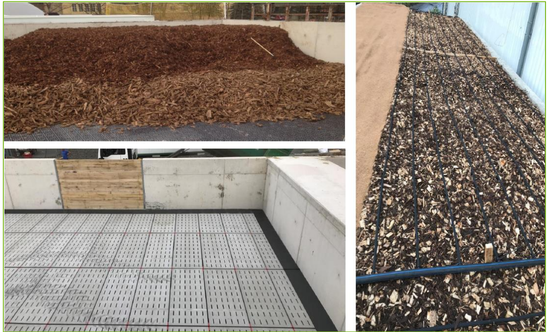
Abb. 6: Aufbau eines Biofilters
