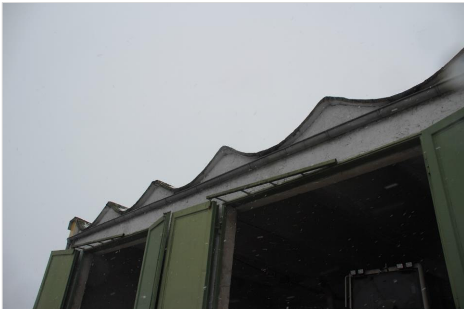
Ostansicht Garage ohne Nachweis von Quartierstrukturen
