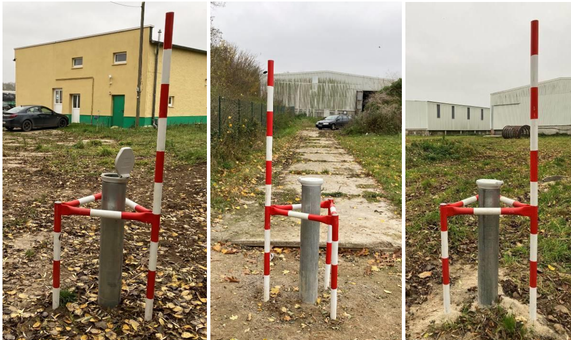
Abbildung 2: Die drei neuen Grundwassermessstellen auf dem Gelände des Kompostwerkes Reinberg
