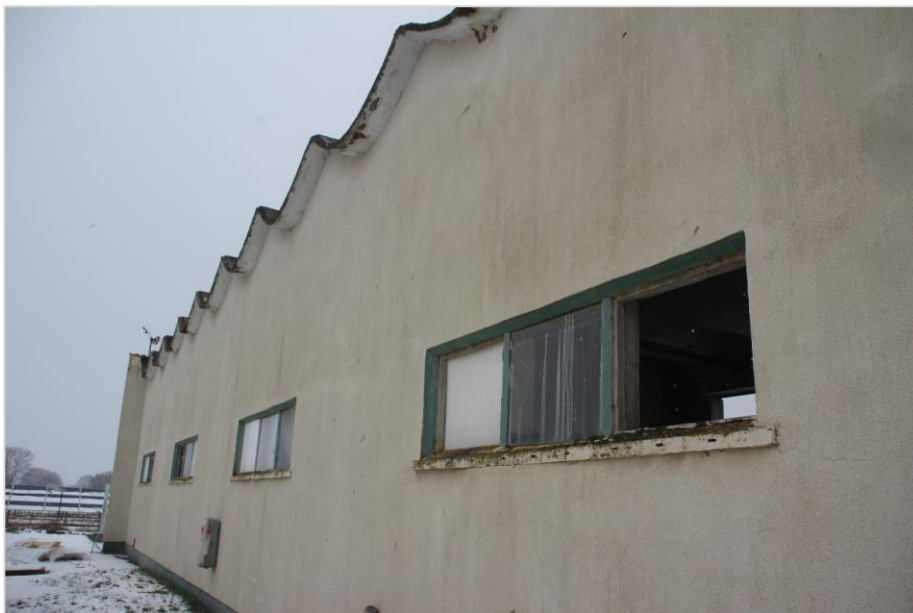
Nordansicht Garage ohne Nachweis von Quartierstrukturen
