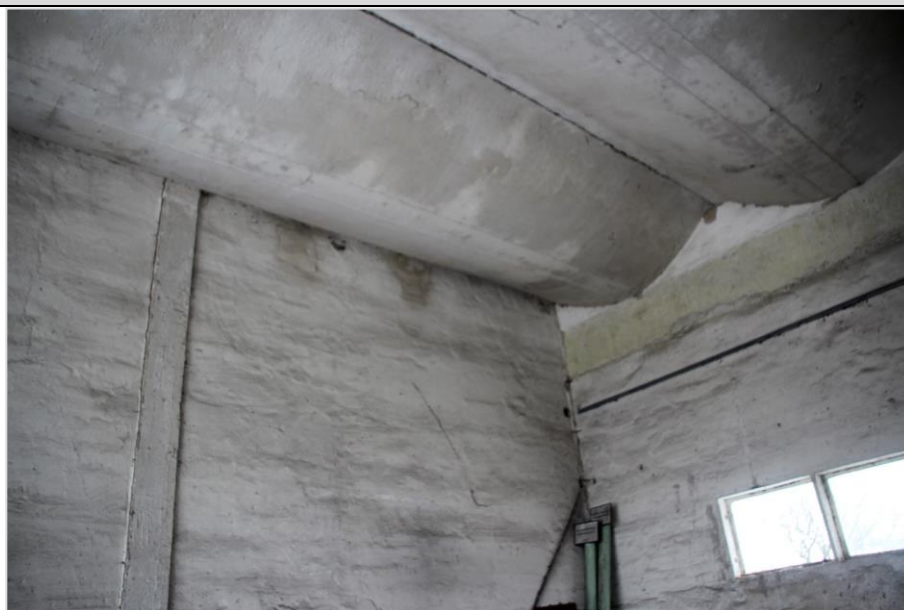
Innenansicht Garage ohne Nachweis von Quartierstrukturen
