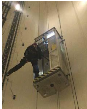
Auf die Leiter steigen und die zweite Fallsicherung anschlagen.
