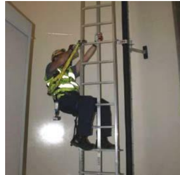
Die Fallsicherung vom Aufzug lösen und auf die Steigseite der Leiter wechseln.
