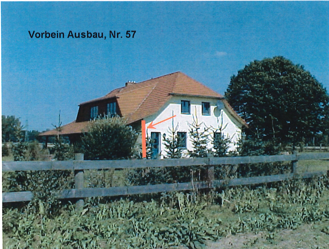
IO-A: Vorbein Ausbau, Nr. 57 (B194)
