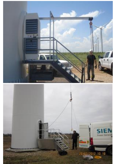
Abbildung 20: Zwei Beispiele für eine gut eingerichteten Service-Zugang zur WEA
