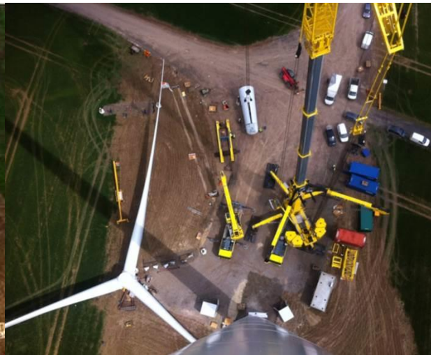
Abbildung 15: Beispiel einer rechteckigen befestigten Stellfläche, mit Rotormontage.
