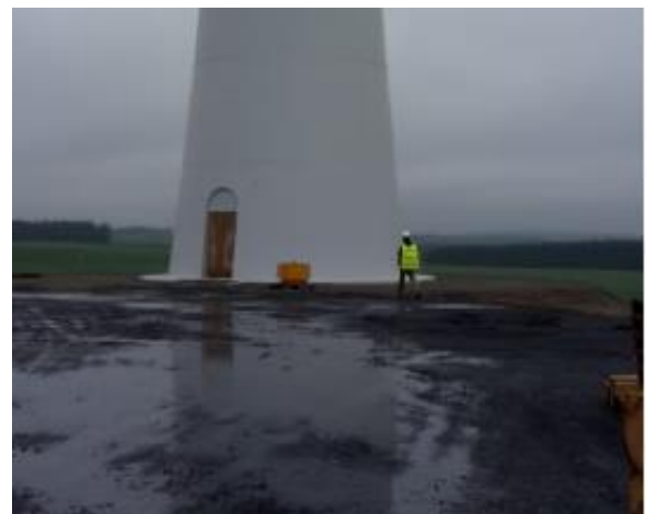
Abbildung 22: Zwei Beispiele für einen eingerichteten Service-Zugang zur WEA
