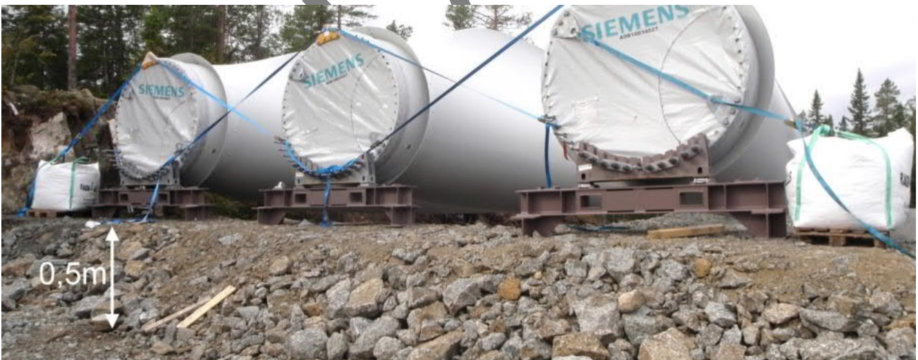
Abbildung 17: Beispiel eines Endes des Bereich für Stützböcke der Rotorblätter q4 .
