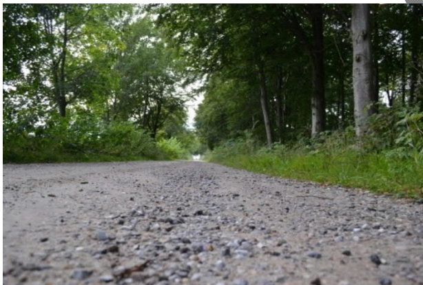
Abbildung 2: Eine gut instandgehaltene Schotterstraße mit Neigung für ordnungsgemäßen Wasserablauf.
