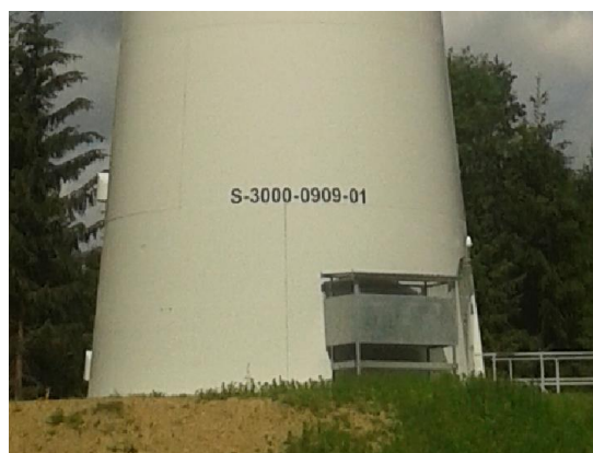
Abbildung 2: Beispielhafte WEA-NIS-Nummer an einer WEA.
