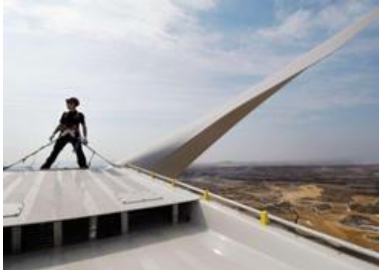
Abbildung 10-2: Arbeiten auf dem Maschinenhaus
