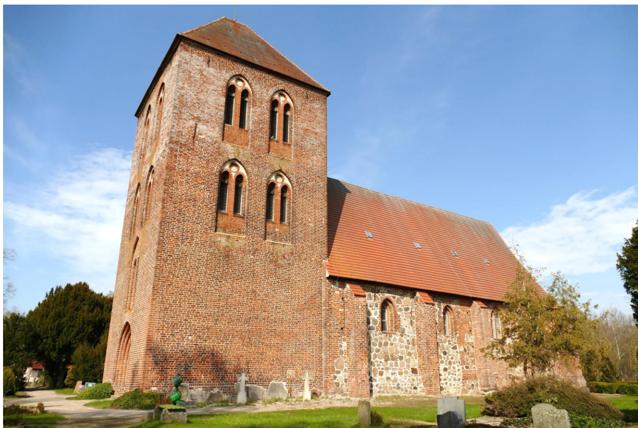
Abbildung 28: Evangelische Kirche Alt Bukow, Südansicht (Foto: WIND-projekt)
