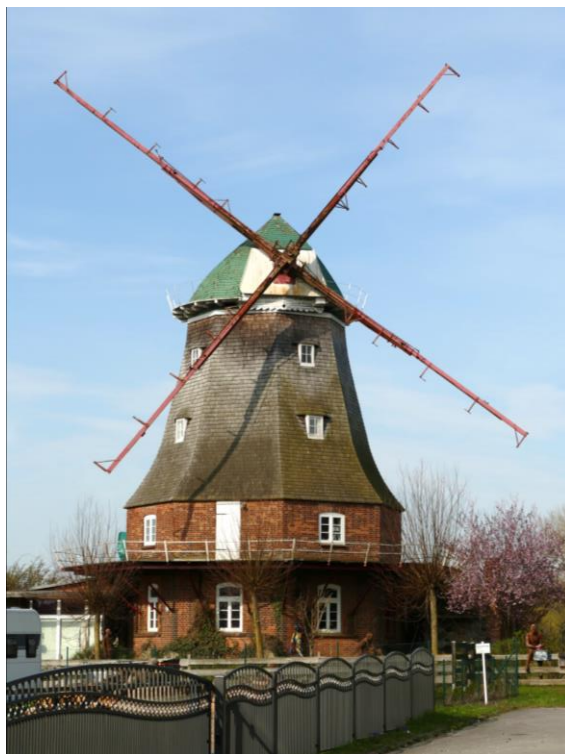
Abbildung 8: Windmühle Neubukow, Westansicht (Foto: WIND-projekt)
