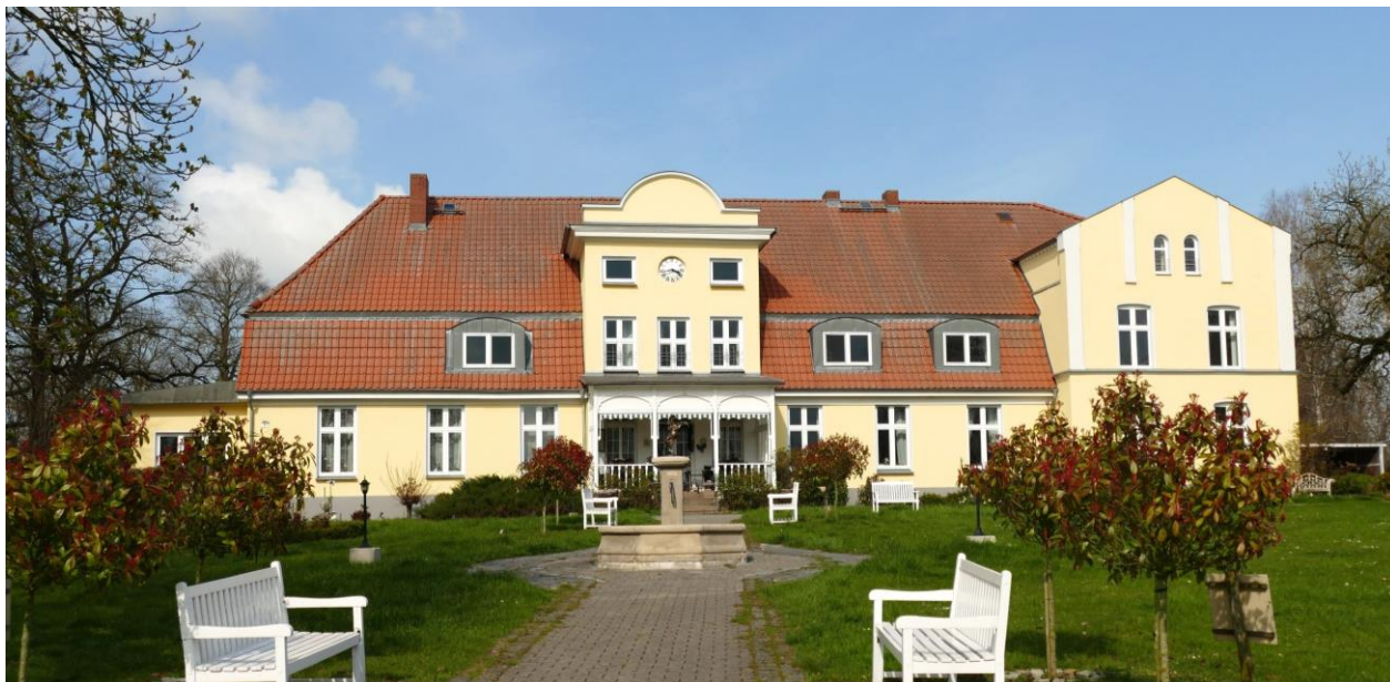
Abbildung 26: Gutshaus Lischow, Südwestansicht (Foto: WIND-projekt)
