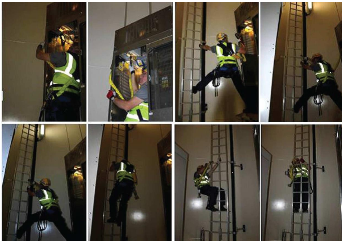
Abbildung 5.27: Ablauf für die Evakuierung aus dem Transportaufzug
