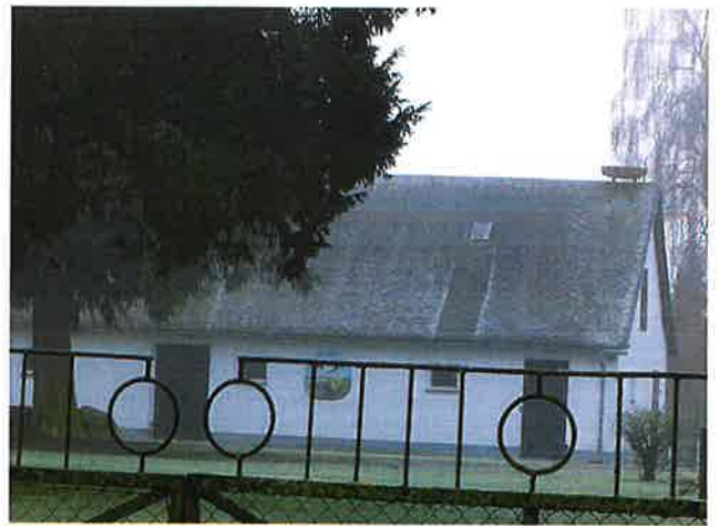
Foto 34, IO 37, Wilmshagen, Kleine Siedlung 5 a Nebengebäude (bewohnt?)
