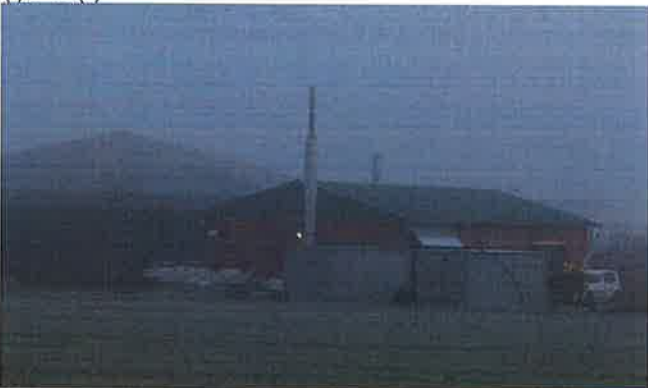
Foto 37, IO 40, Segebadenhau, Biogasanlage, Büro
