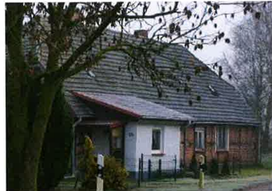
Foto 10: IO 10, Willerswalde, Nr. 17a/b
