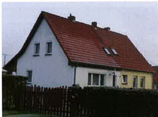
Foto 9: IO 9, Willerswalde, Nr. 14a/b
