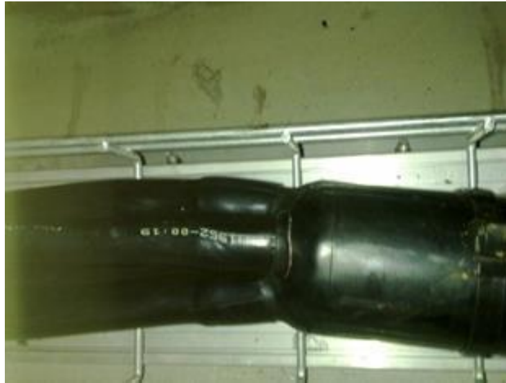
Abbildung 7-1: Risse im Schrumpfschlauch des Mittelspannungskabels.
