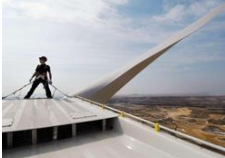
Abbildung 11-1: Arbeiten auf dem Maschinenhaus
