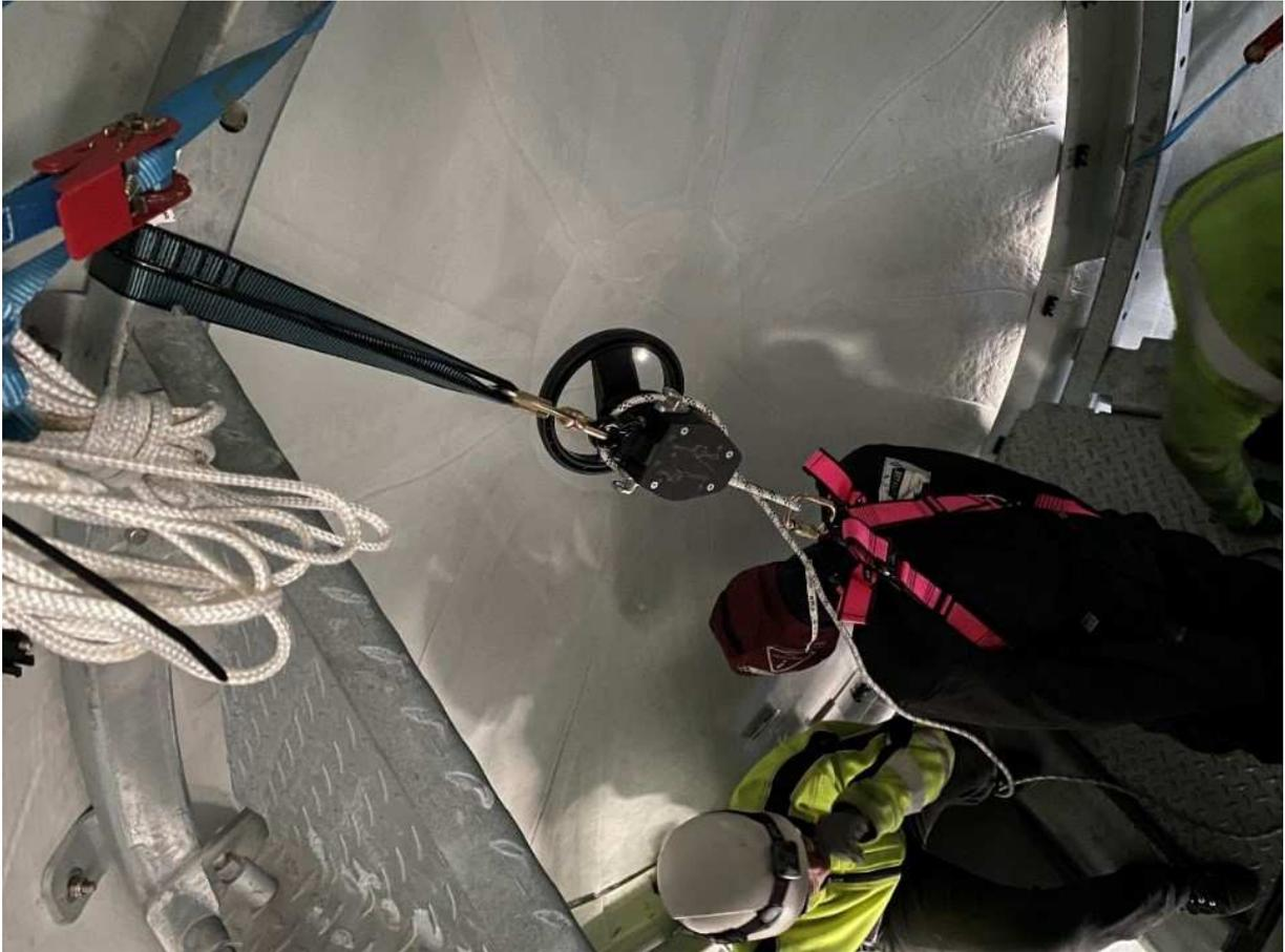
**Abbildung 7.30: Aufhängung der Notabstiegsvorrichtung an der Spinnerringkonstruktion**
