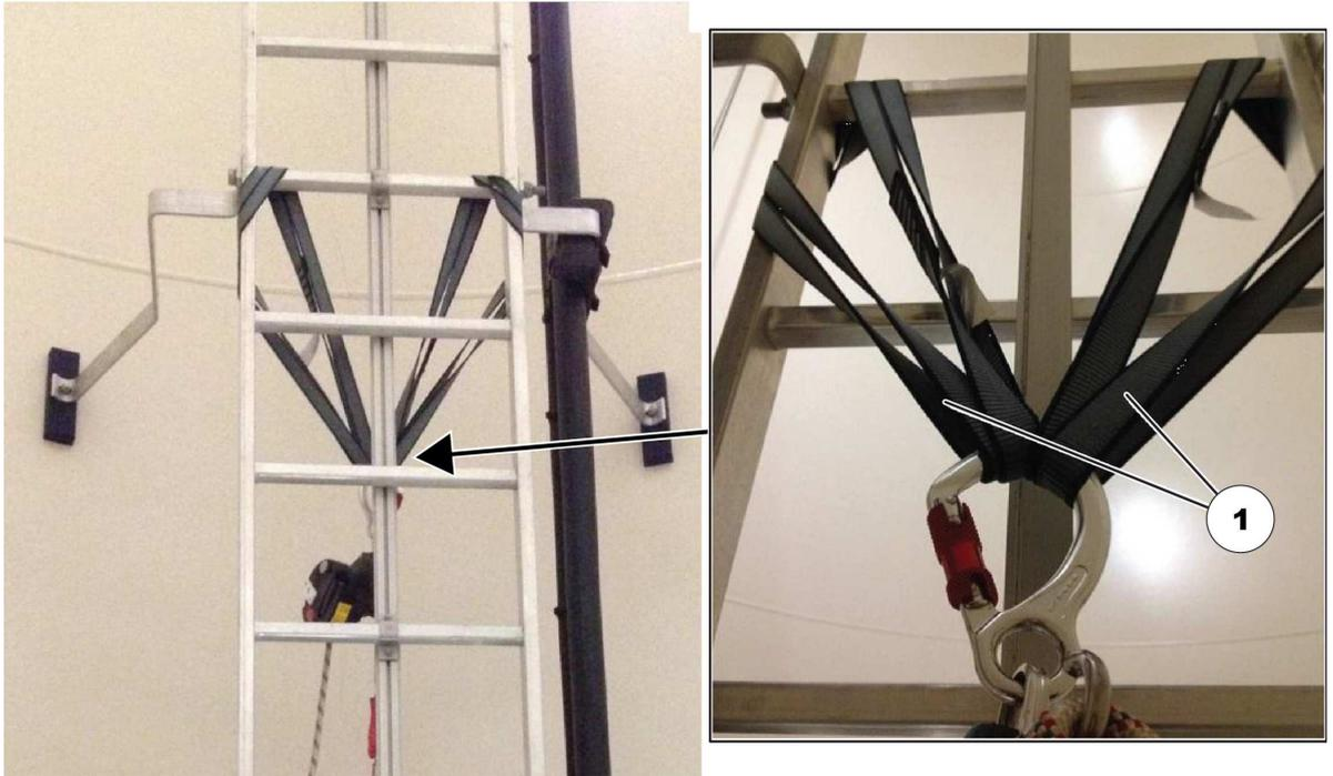
**Abbildung 7.35: An der Turmleiter befestigte Notabstiegsvorrichtung**
