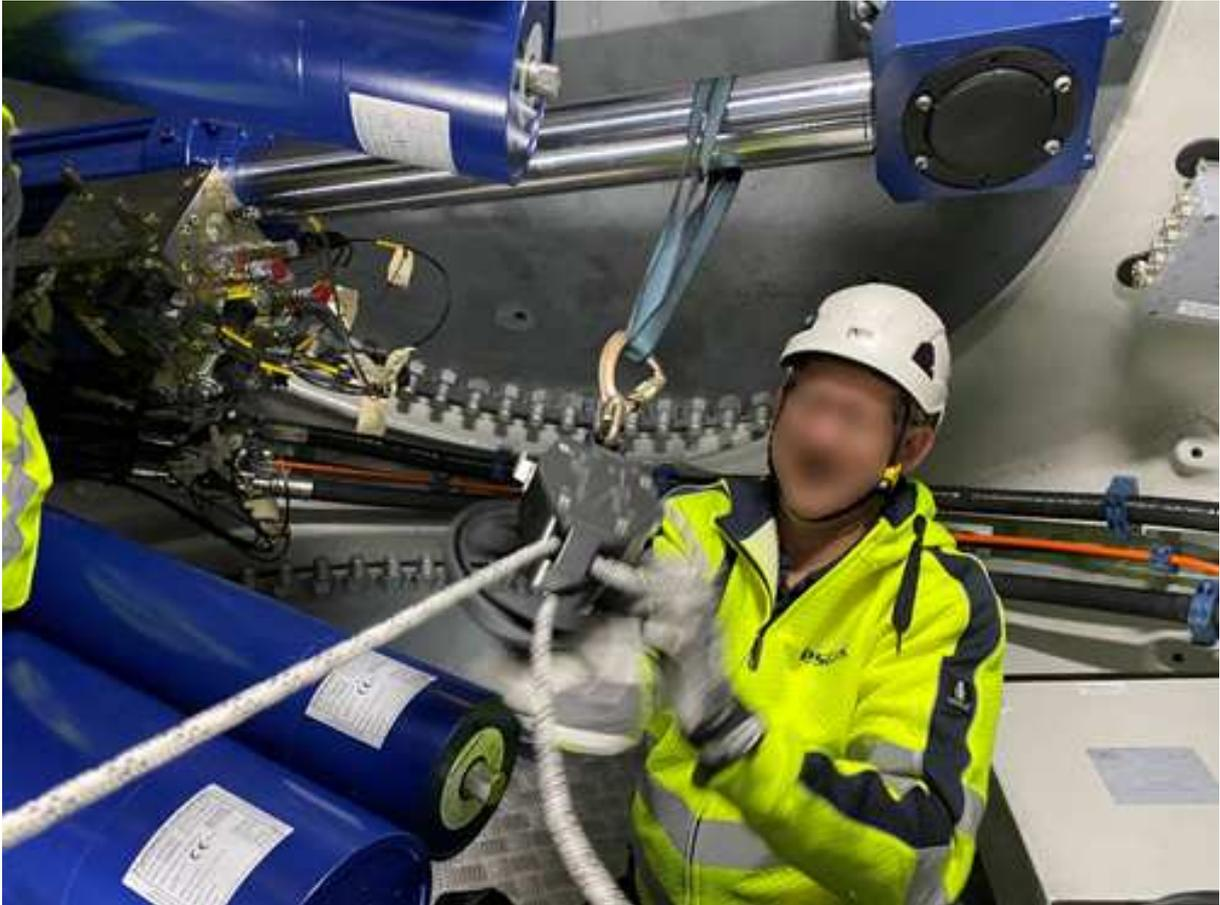
**Abbildung 7.27: Befestigung der Notabstiegsvorrichtung am Pitchzylinder**
