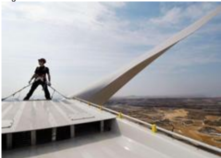
Abbildung 10-2: Arbeiten auf dem Maschinenhaus
