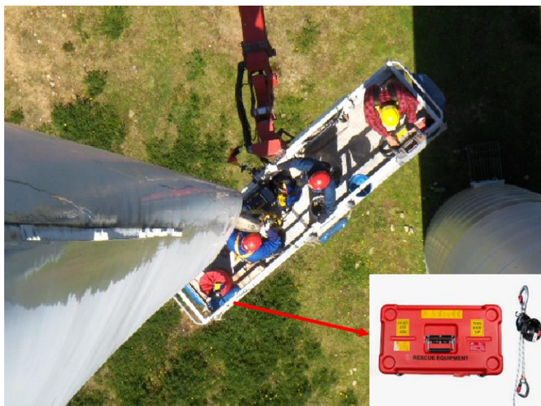
Abbildung 10-1: Beispiel für einen Notabstieg an einem Mannkorb
