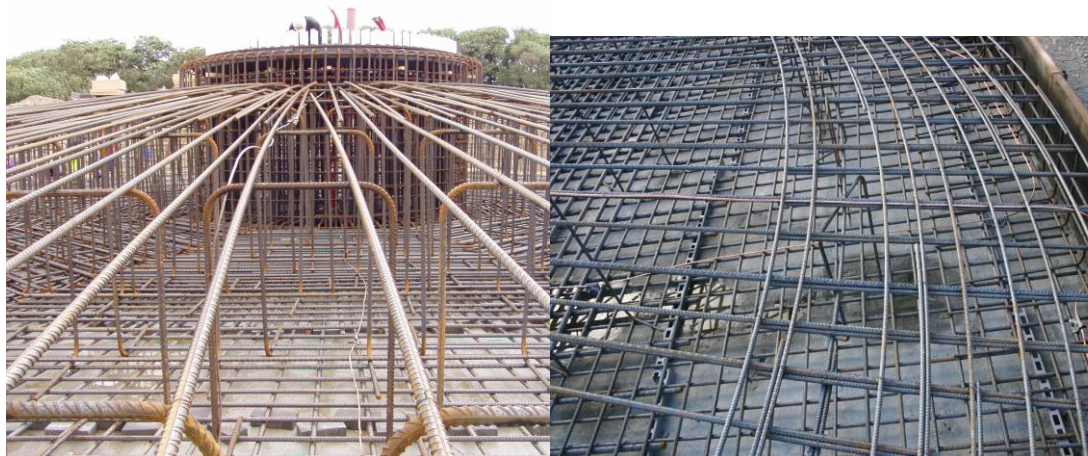
Abbildung 4-13: Mit der oberen Stahlbewehrung verbundenes Erdungskabel
