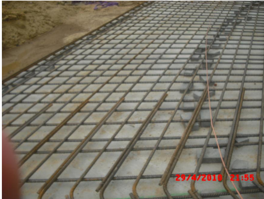
Abbildung 4-4: Entlang des Randes verlaufendes Erdungsseil
