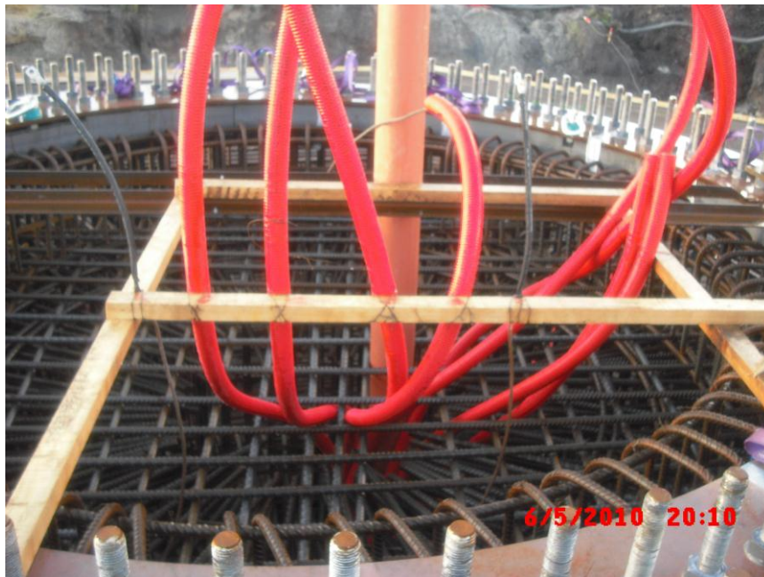
Abbildung 4-3: Zwecks fester Positionierung vor der Betonierung an einem Holzbalken fixiertes Erdungskabel
