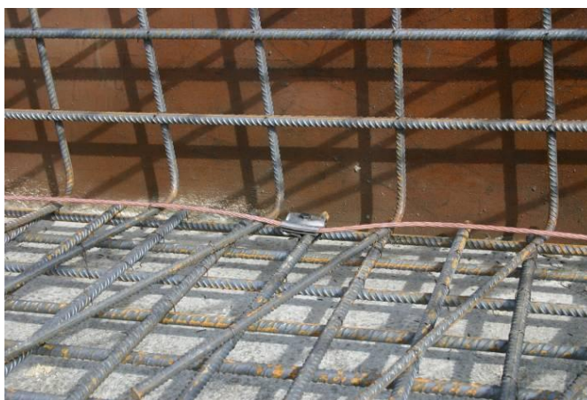
Abbildung 4-10: Mithilfe einer Anschlussklemme an den Stahlbewehrungsstäben verbundenes Erdungskabel
