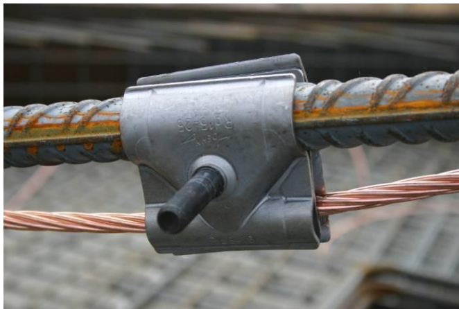
Abbildung 4-9: Mithilfe einer Anschlussklemme an den Stahlbewehrungsstäben verbundenes Erdungskabel
