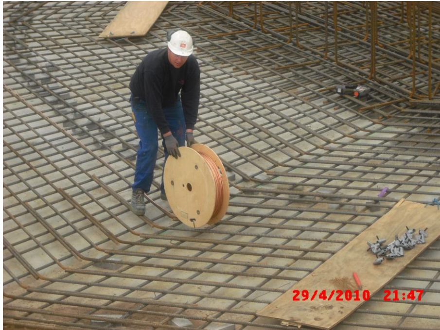
Abbildung 4-1: Ausrollen des Erdungsseils auf der Fundamentsektion
