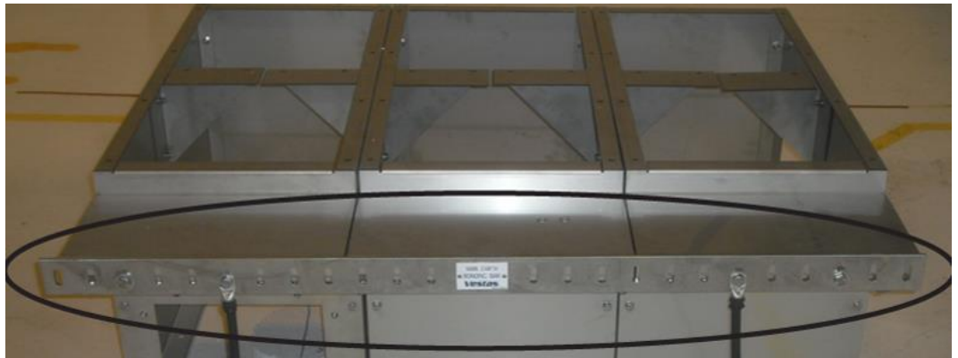
Abbildung 2-3: Auf der Rückseite eines Grundrahmens mit drei Konsolen montierte Haupterdungsschiene.
