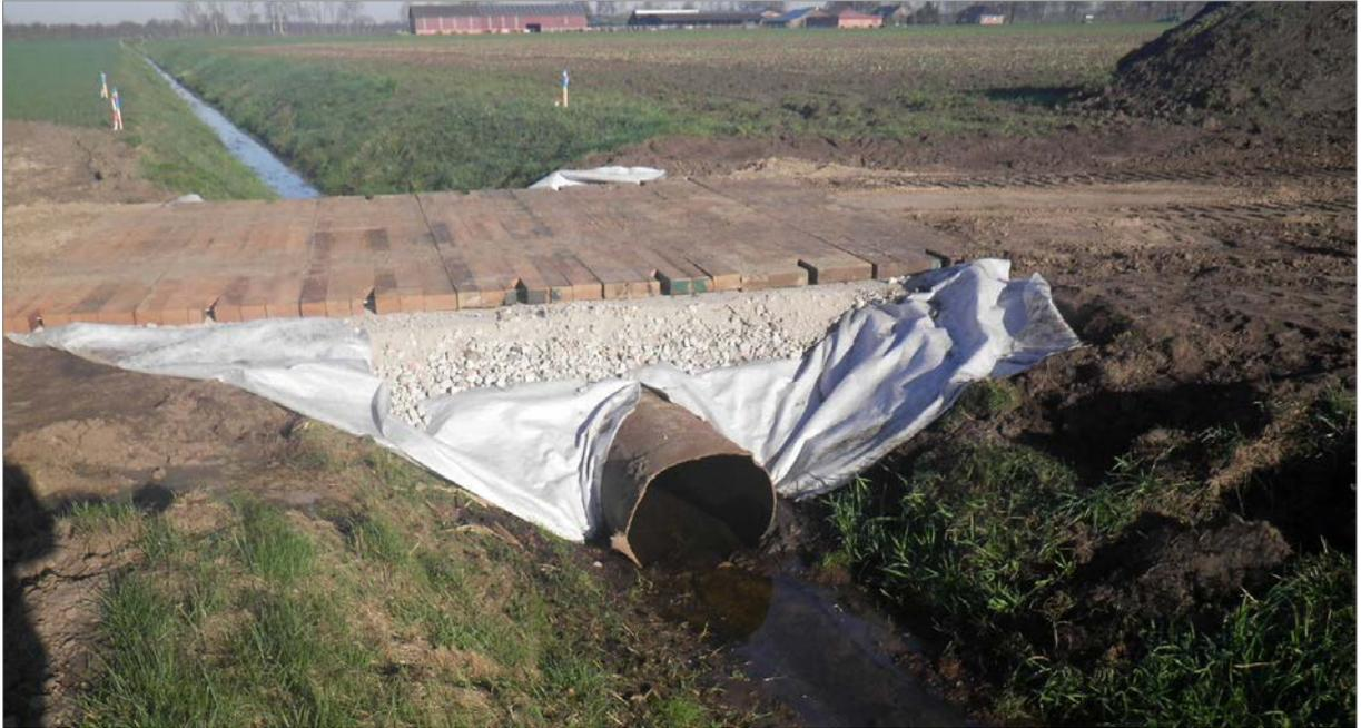
Abbildung 5: *Beispielhafte Gewässerüberfahrt mittels temporärem Rohrdurchlass*
