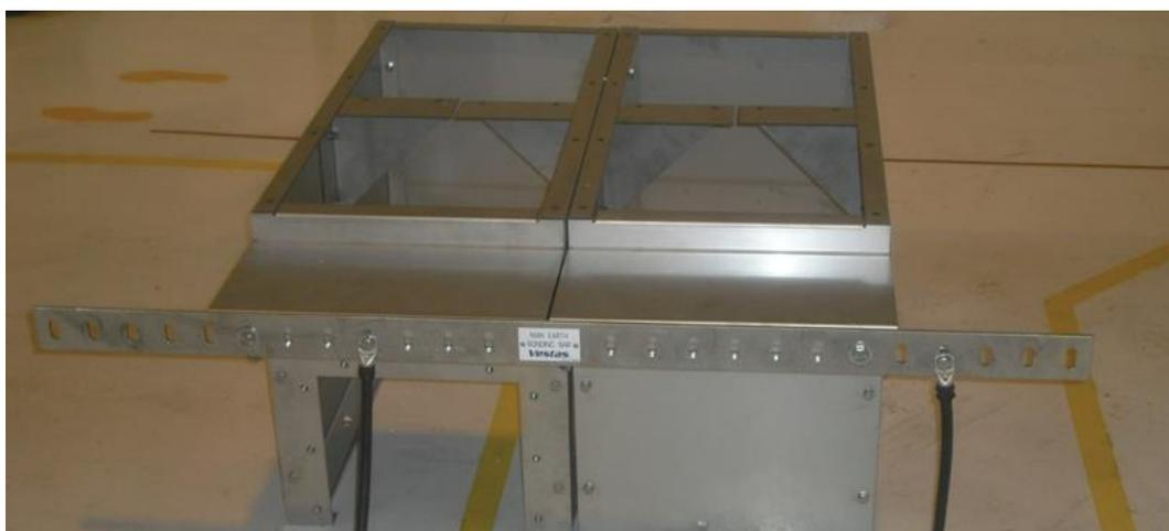
Abbildung 4-18: Erdungskabel (Kabelschuhe) verbunden mit der Haupterdungsschiene am Grundrahmen einer Schaltanlage mit zwei Schaltfeldern
