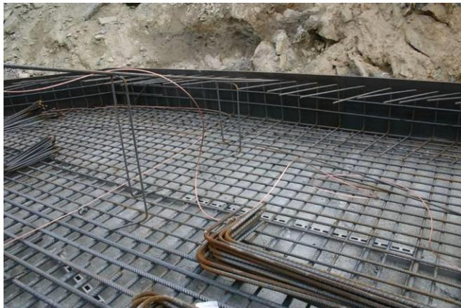
Abbildung 4-8: Spielraum für die spätere Verbindung mit den oberen Stahlbewehrungsstäben
