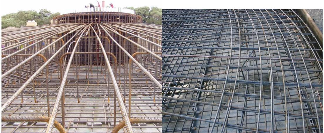
Abbildung 4-13: Mit der oberen Stahlbewehrung verbundenes Erdungskabel
