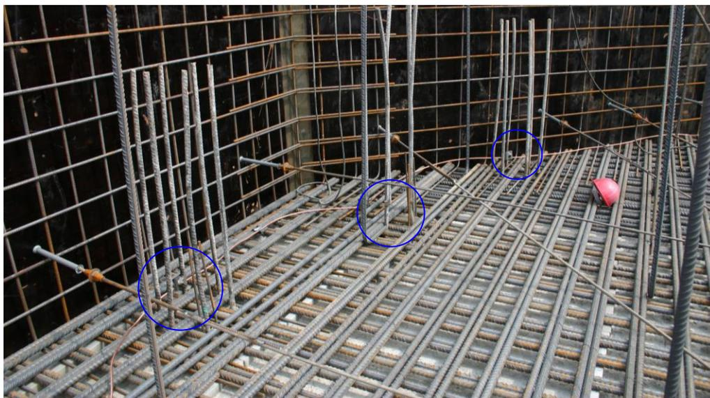
*Abbildung 6-2: Mittels Anschlussklemmen mit den Stahlbewehrungsstäben der Tiefgründungspfähle verbundene Kupfererdungskabel*
