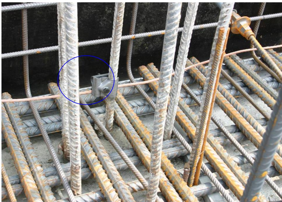
Abbildung 6-1: Mittels einer Anschlussklemme mit dem Stahlbewehrungsstab des Tiefgründungspfahls verbundenes Kupfererdungskabel
