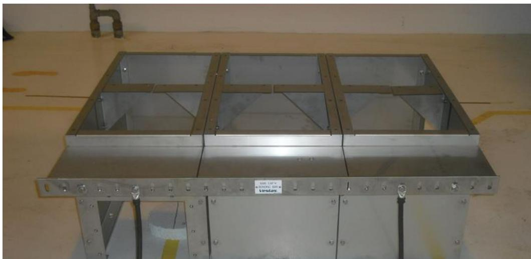
Abbildung 4-17: Erdungskabel (Kabelschuhe) verbunden mit der Haupterdungsschiene am Grundrahmen einer Schaltanlage mit drei Schaltfeldern
