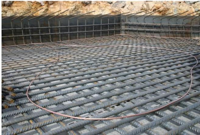
Abbildung 4-7: Locker verteiltes überschüssiges Erdungskabel
