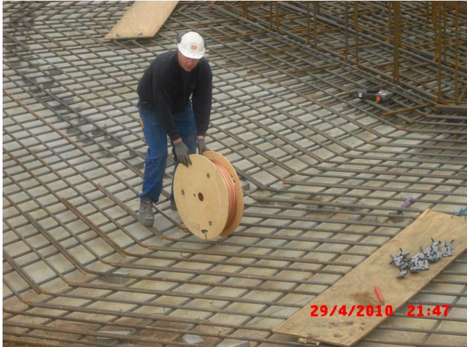
Abbildung 4-1: Ausrollen des Erdungsseils auf der Fundamentsektion
