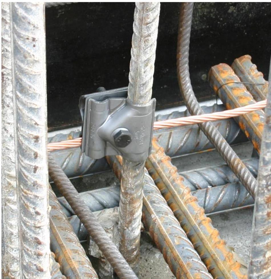
*Abbildung 6-3: Mittels Anschlussklemmen mit den vertikalen Stahlbewehrungsstäben der Tiefgründungspfähle verbundenes Kupfererdungskabel*
