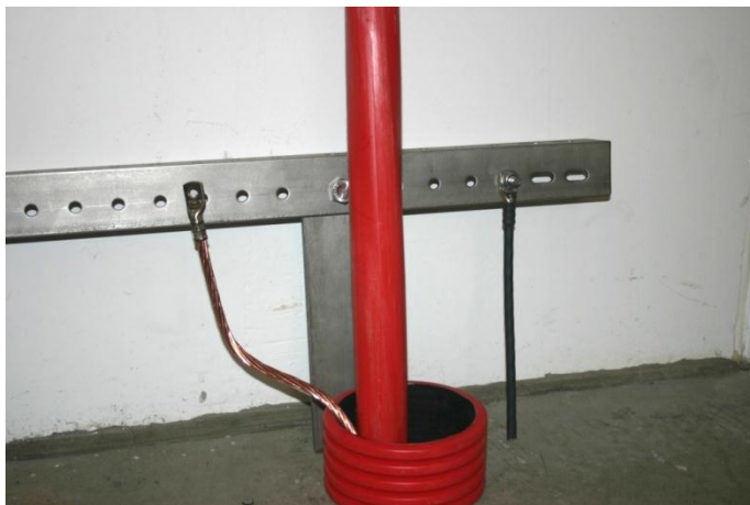
Abbildung 7-2: Montierter Kabelschuh am Erdverbindungskabel
