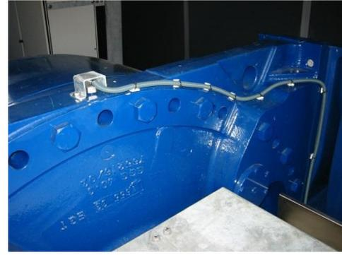
Abbildung 5-3: Sensorkabel wird in einem flexiblen Kabelschuttschlauch geführt
