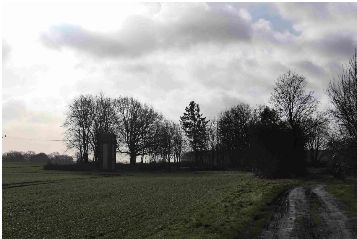
Abbildung 14: Blick auf Transformatorenhaus in leicht südöstliche Richtung ausgehend von nördlich verlaufendem Feldweg (Nr. 10 lt. Tab. 5). Foto: SLF 01.02.2024.
