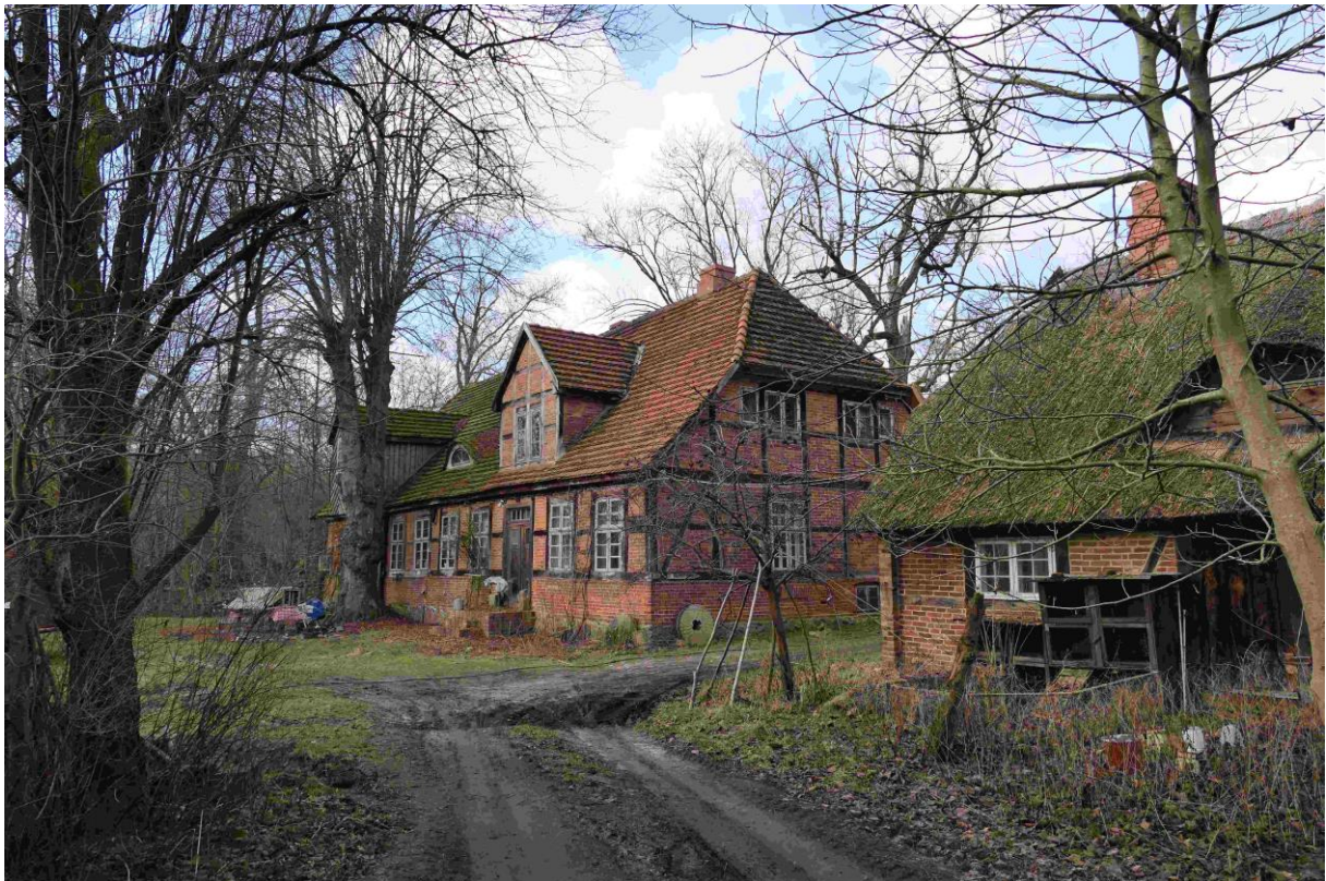
Abbildung 30: Blick auf denkmalgeschützte Wassermühle in Waldbereich südlich Vellahn (Nr. 23 lt. Tab. 7). Foto: SLF 01.02.2024.
