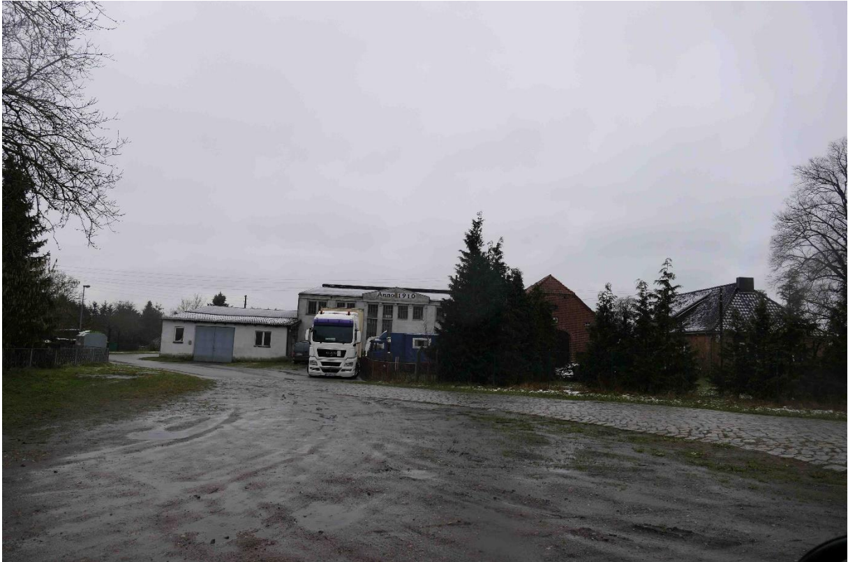
Abbildung 37: Blick nach Westen auf ehemaliges Maschinenhaus am rechten Bildrand (Nr. 36 lt. Tab. 10) mit vorgelagerten, optisch bedrängenden Gebäuden und Großfahrzeug. Foto: SLF 09.02.2024.
