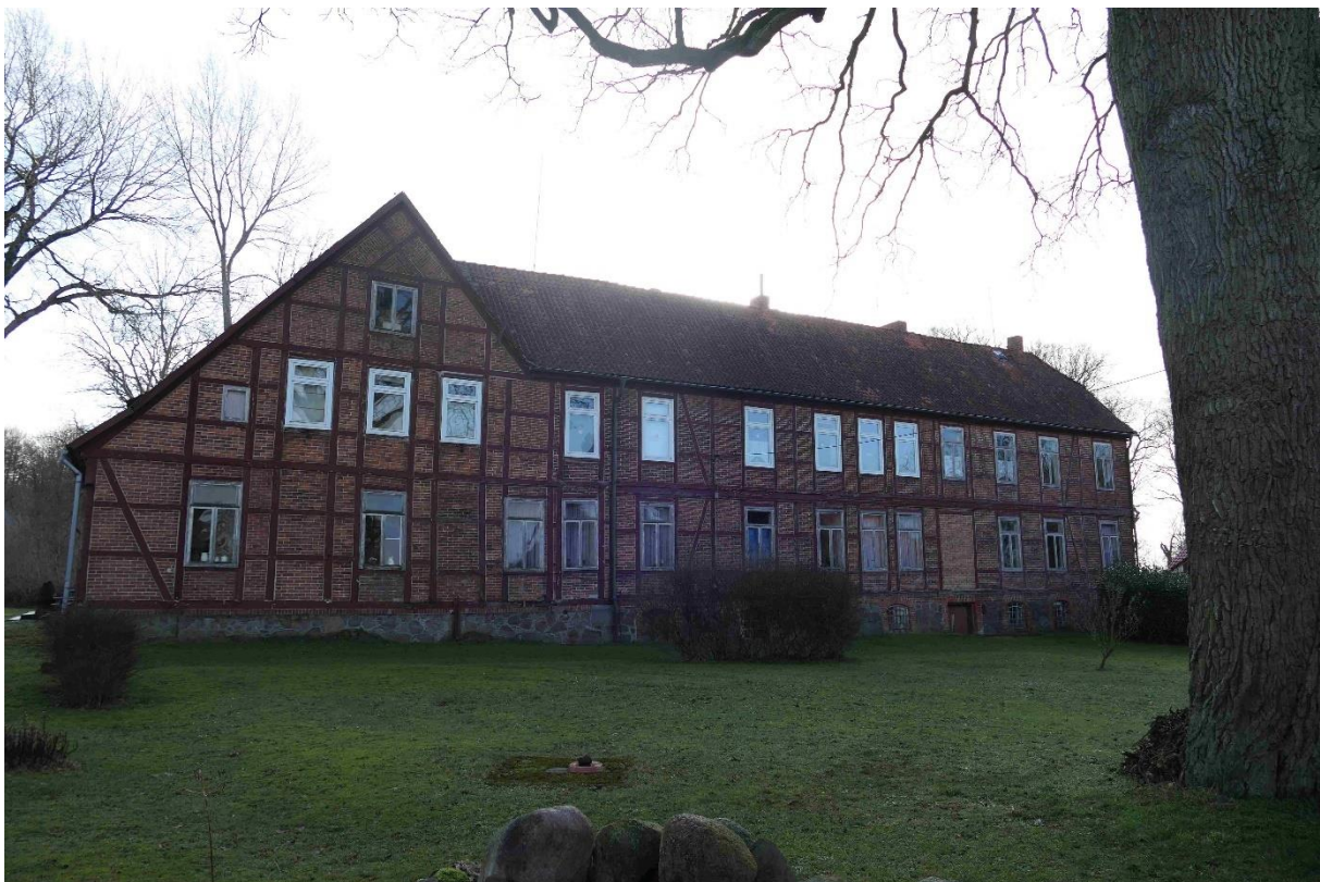
Abbildung 6: Blick auf die Gutsanlage (Nr. 4 lt. Tab. 3) in südliche Richtung Foto: SLF 01.02.2024.
