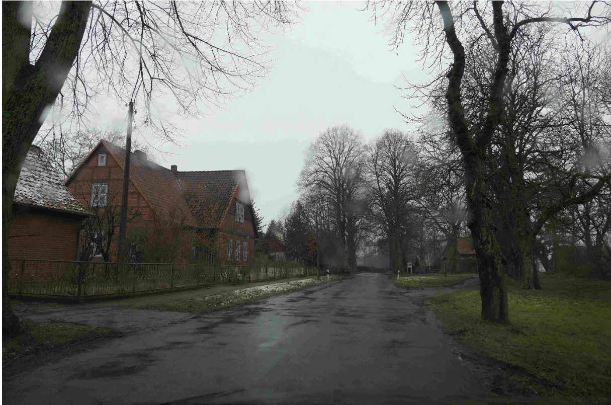
Abbildung 44: Blick auf ehemaliges Schulgebäude in Marsow ausgehend von westlich verlaufenden Kirchenstraße in Richtung Südost (Nr. 45 lt. Tab. 12). Foto: SLF 09.02.2024.
