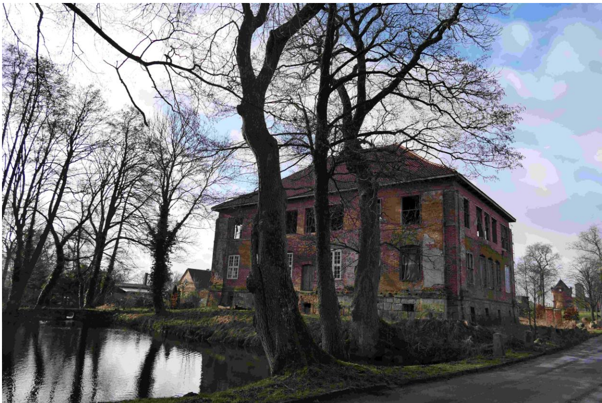
Abbildung 10: Blick auf Schlossruine in Goldenbow in südwestliche Richtung ausgehend von nördlich verlaufender Straße „Zum Wasserturm“ (Nr. 8 lt. Tab. 4). Foto: SLF 01.02.2024.
