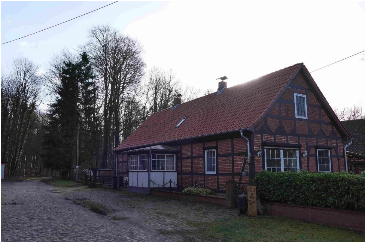
Abbildung 7: Blick auf Wohnhaus im Parkweg in südliche Richtung (Nr. 5 lt. Tab. 3). Foto: SLF 01.02.2024.
