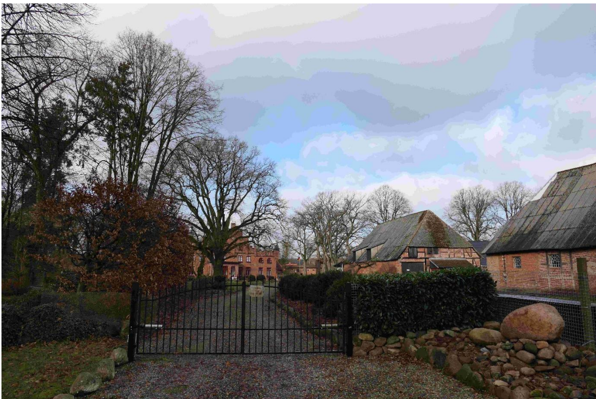
Abbildung 17: Blick auf Gutshaus (Mitte) und Scheunen (rechter Bildrand) in Richtung Vorhaben (Nr. 11 bis 13 lt. Tab. 6). Foto: SLF 01.02.2024.
