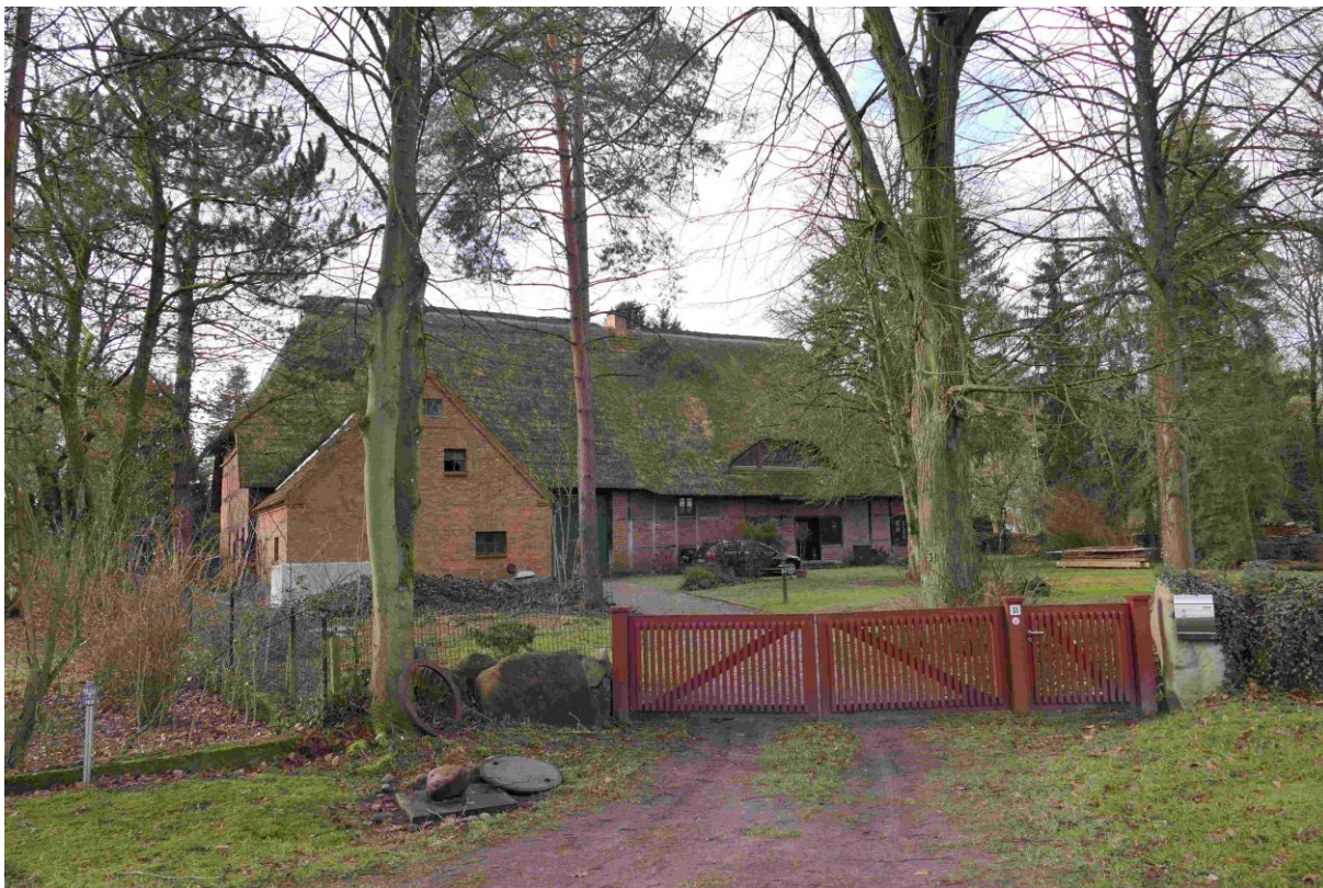
Abbildung 18: Blick auf ehemaliges Wirtschaftsgebäude in Richtung Vorhaben (Nr. 14 lt. Tab. 6). Foto: SLF 01.02.2024.
