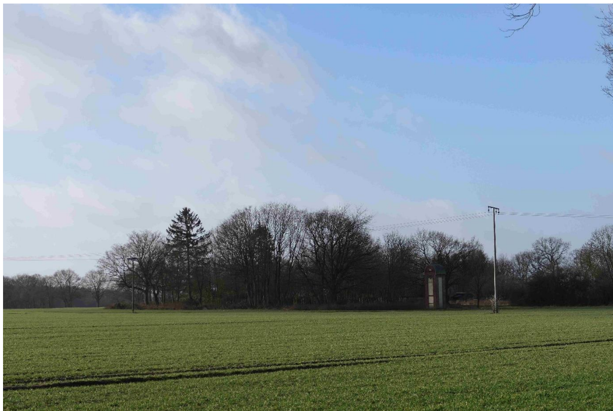
Abbildung 15: Blick auf Transformatorenhaus in Richtung Vorhaben nach Südwesten (Nr. 10 lt. Tab. 5). Foto: SLF 01.02.2024.
