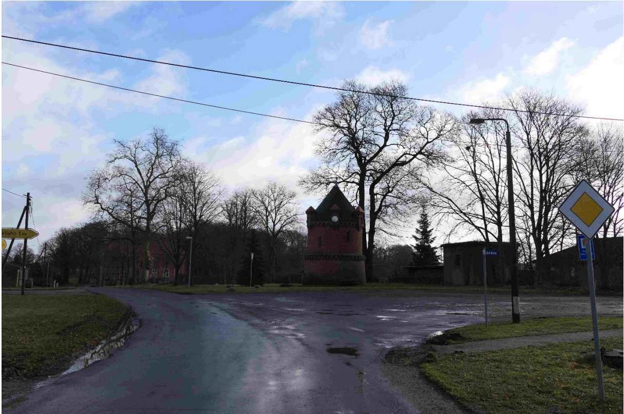
Abbildung 11: Hauptansicht auf Wasserturm in Goldenbow in südöstliche Richtung ausgehend von nördlich verlaufender Straße „Zum Wasserturm“ (Nr. 9 lt. Tab. 4). Foto: SLF 01.02.2024.
