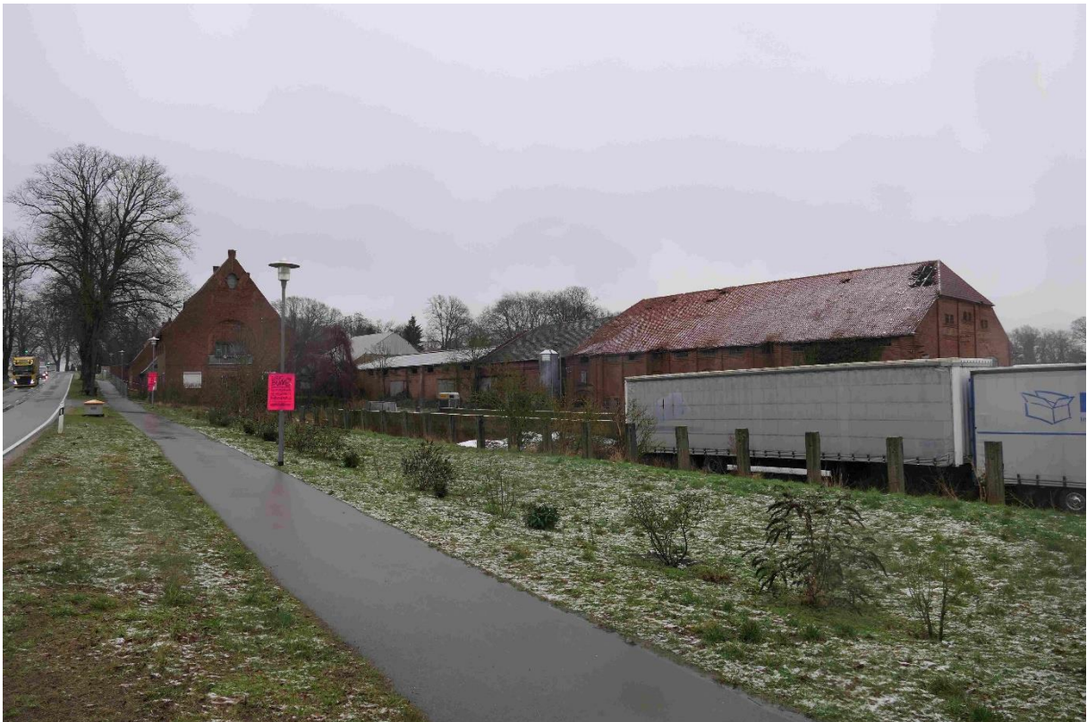
Abbildung 38: Blick auf baufällige, ehemalige Hochfahrtscheune im rechten Bildrand (Nr. 32 lt. Tab. 10). Foto: SLF 09.02.2021
