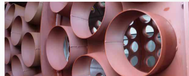
Wickelschutz durch Rohrhülsen
