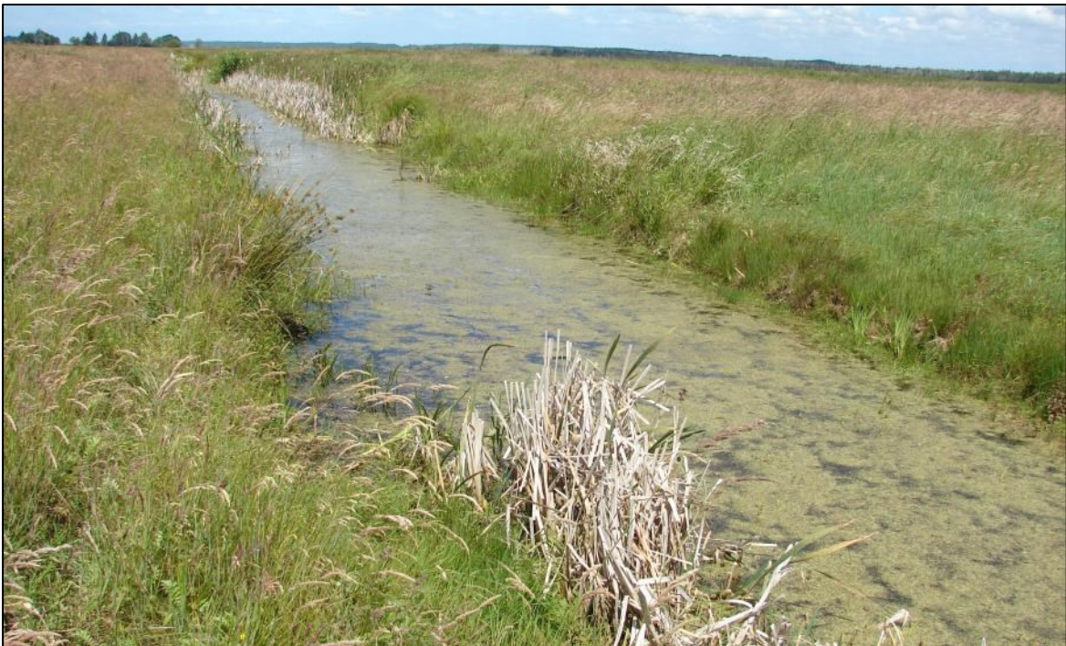
Anlage 3 a - Stichgraben zwischen Grenztaunmoor und ruderalen Grünland (östlicher „engerer Untersuchungsraum“)
