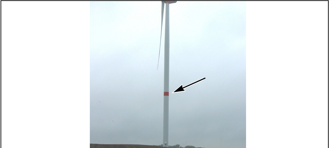
Abb. 4: Roter Farbring an Anlage mit Gesamthöhe >150 m
