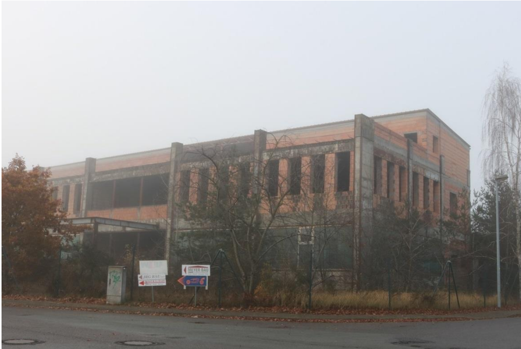
IP FH: verfall. Gebäude Gewerbering 14, Lübesse
