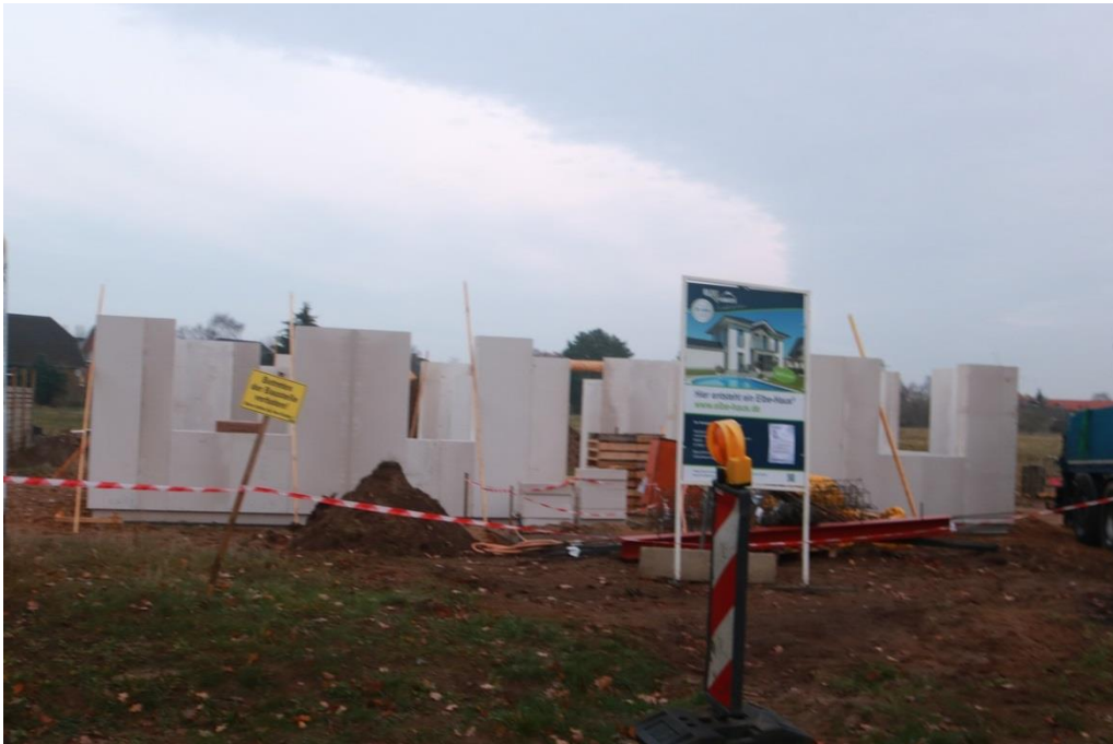
IP CL: Neubau An der Kartoffelhalle, Sülte
