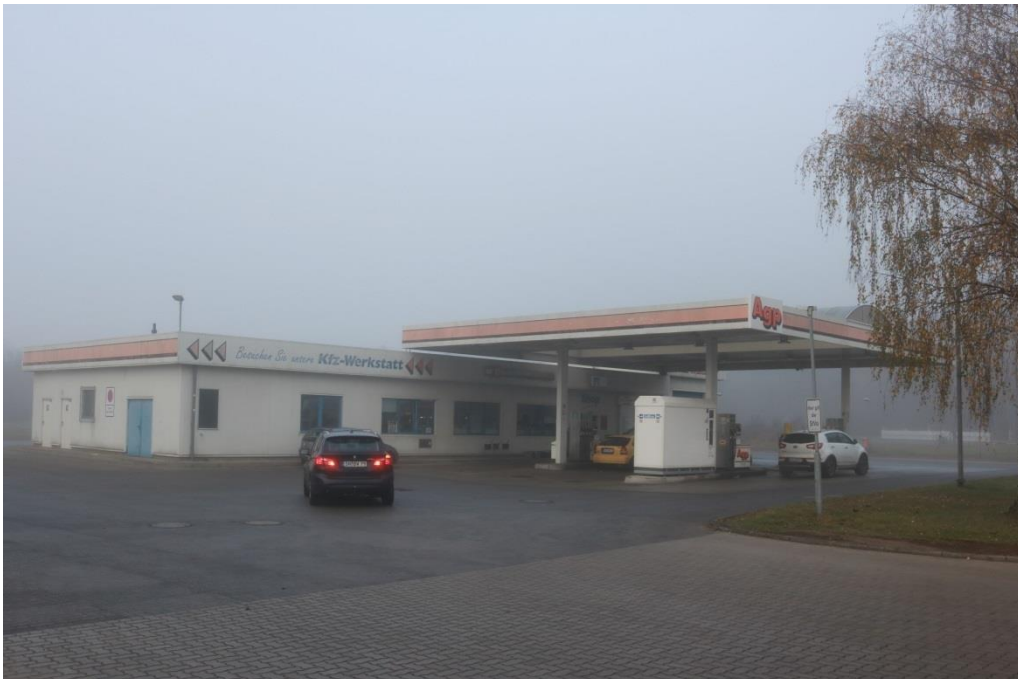
IP EQ: Tankstelle Schweriner Str. 2d, Lübesse
