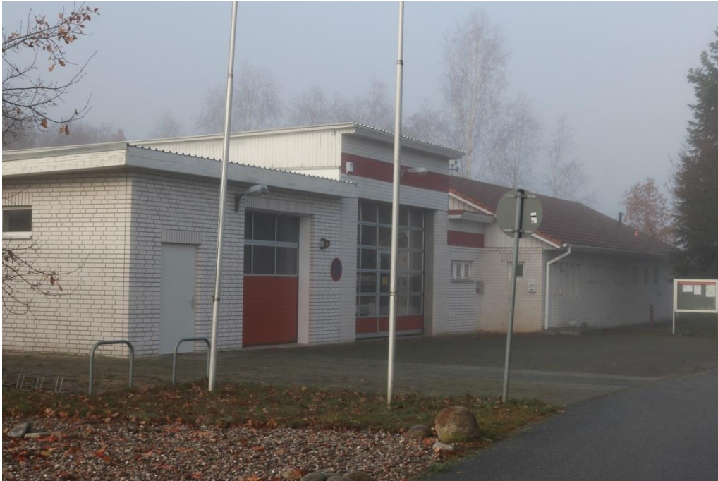
IP DS: Feuerwehr Schweriner Str. 18, Lübesse
