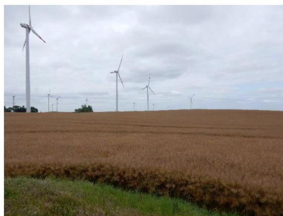
Abbildung 6.6: Blick in Richtung Süd-West
