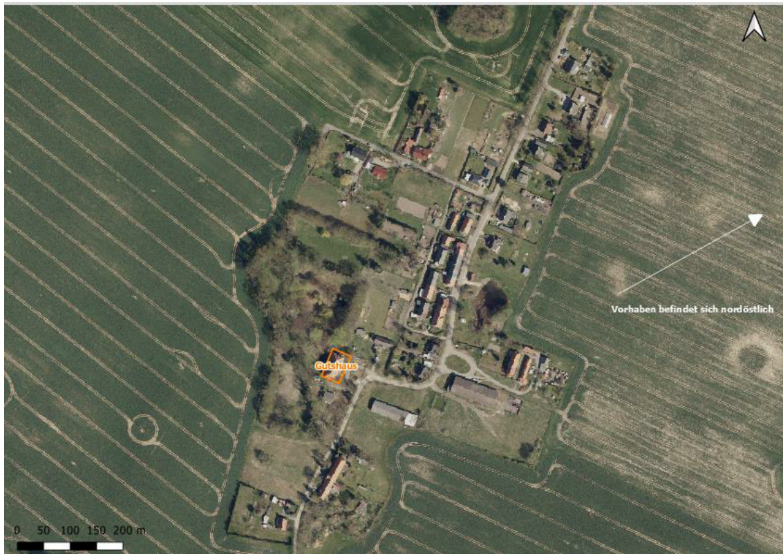
Abbildung 34: Luftbild mit Kennzeichnung der Baudenkmale in Beckendorf. Erstellt mit QGIS 3.2, Kartengrundlage: DOP, LAiV M-V 2021.
