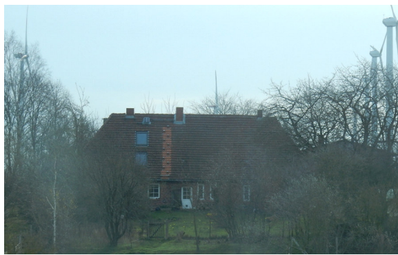
Bild 17: IO 17, Kladrum, Ausbau
