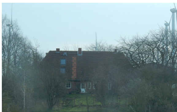
Bild 21: IO 20, Kladrum, Ausbau
