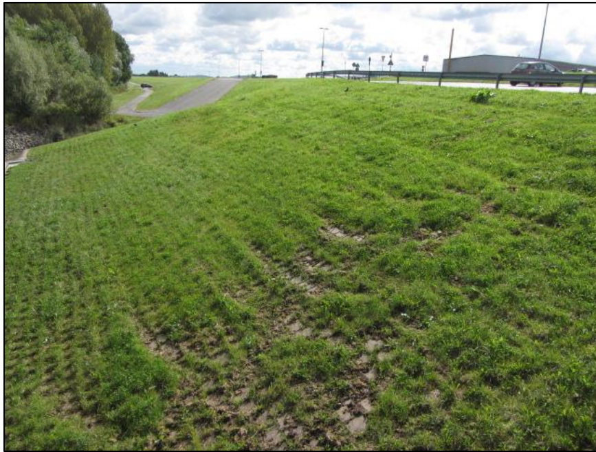
Foto 2: Deich, elbseitig mit Befestigungsstrukturen
