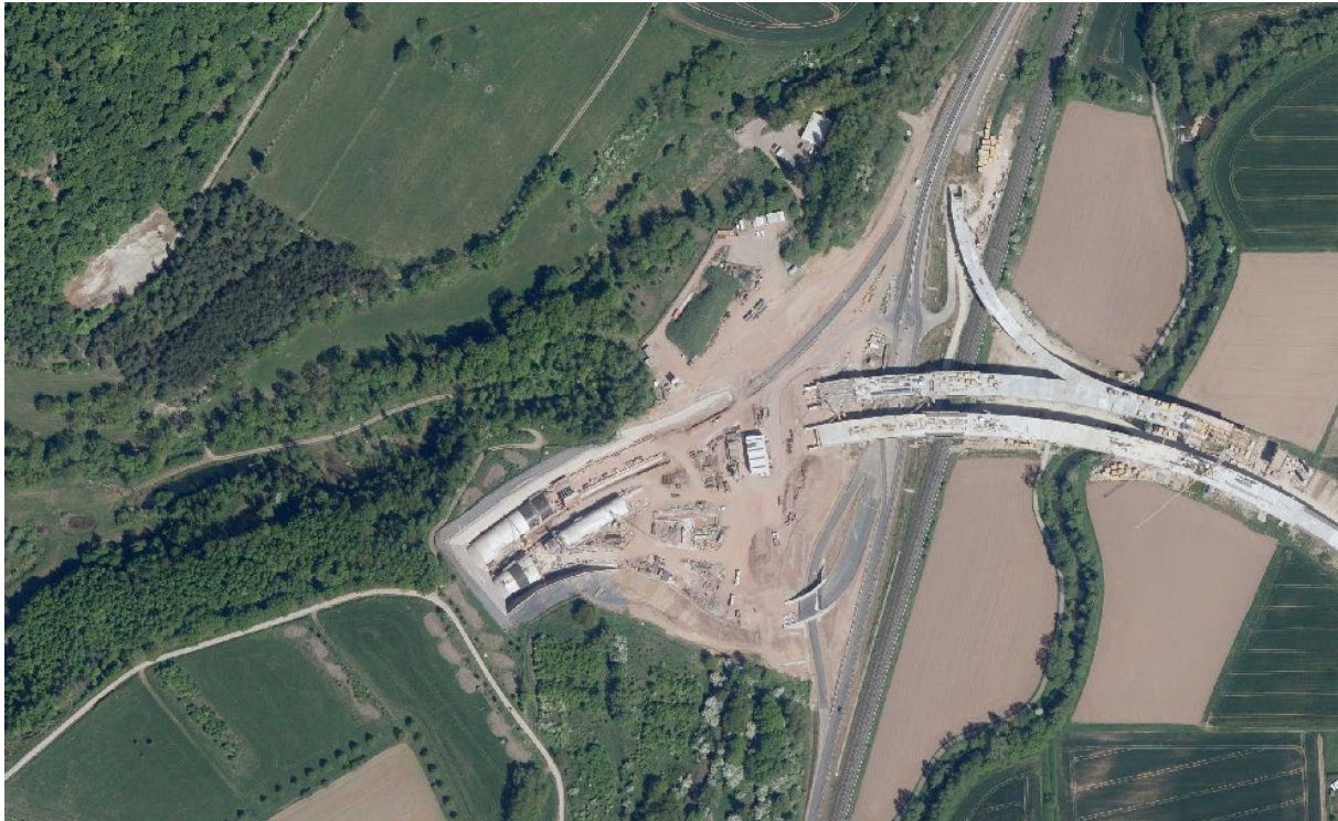
Abbildung 8: Totalzerschneidung des alten Bahndamms parallel der B27 auf ca. 300 m Länge durch die Baustelle der A44 (GoogleMaps, Mai 2021).
