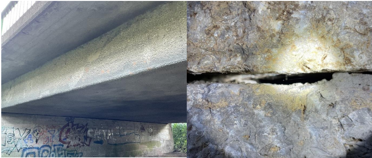
Abb. 4-48: Dehnungsfuge (seitlich und oberhalb) als Quartierpotential
