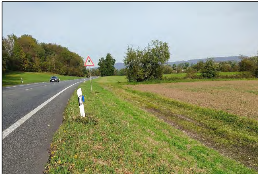
Abb. 6-9: Böschungsbereiche an der B27 im Norden des UGs B452 NU
