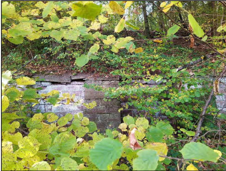
Abb. 6-12: Mauer am alten Bahndamm nahe der B27
