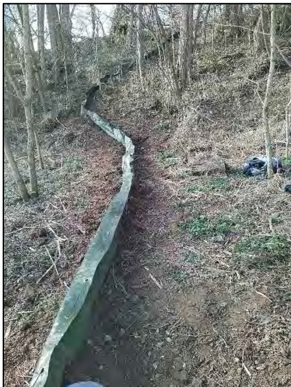
Abb. 5-1: Amphibienzaun von B27 hoch zum Bahndamm
