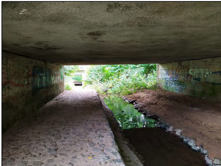
Abb. 7-6: Vierbach unter der B27 (Unterführung)
