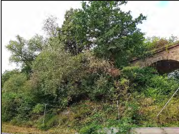
Abb. 4-11: Brücke alter Bahndamm über L3243, dichter Gehölzbewuchs (PF Nr. 4)
