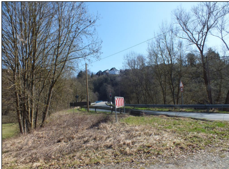
Abbildung 1: einspurige Lahnbrücke mit Lichtsignalsteuerung
