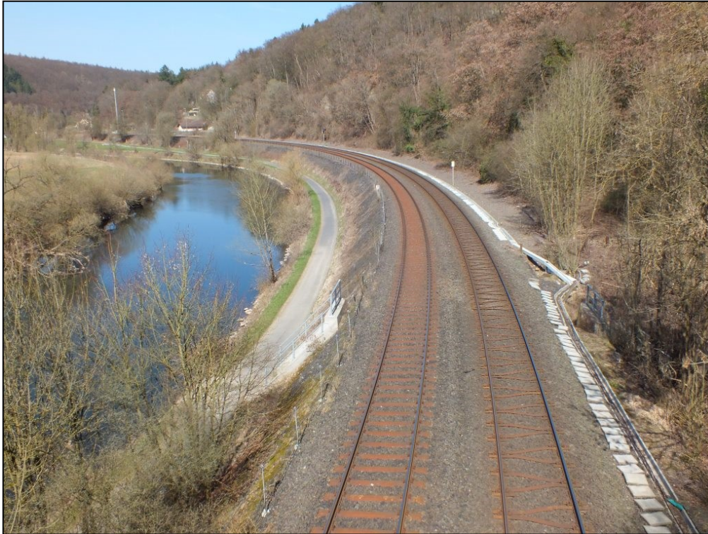
Abbildung 8: Blick von der alten Lahnbrücke nach Norden in Richtung Campingplatz mit Darstellung des stark anthropogen überprägten östlichen Lahnufers mit Bahnlinie und dem eng trassierten Radweg R7 Auf Höhe des Campingplatzes liegen mit dem Bahnhof Gräveneck und einigen Wohnhäusern nur kleine Siedlungsflächen innerhalb des UGs.
