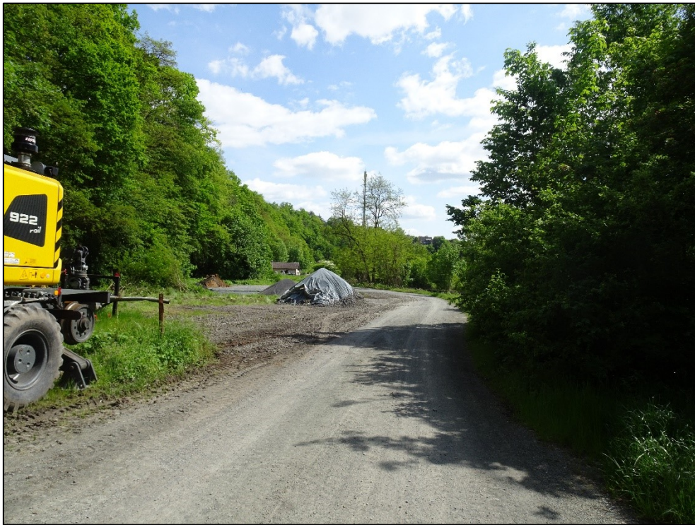
Abbildung 20: Neuer Straßenverlauf am östlichen Beginn der neuen Lahnbrücke. Im Hintergrund ist die Kläranlage von Gräveneck zu erkennen.
