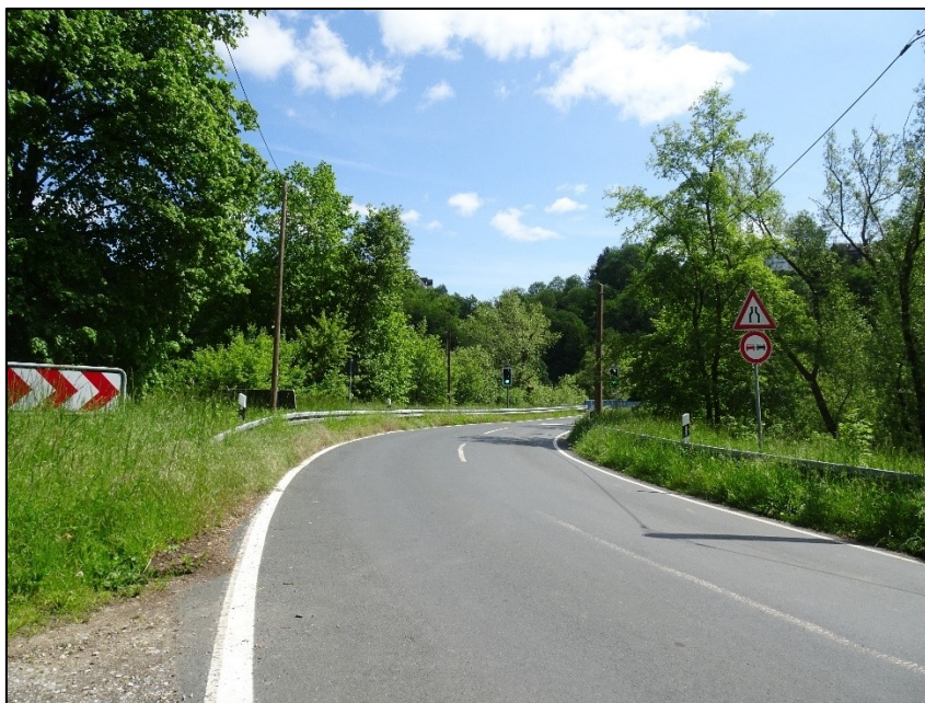
Abbildung 2: Blick auf das Baufeld im Bereich des westlichen Brückenkopfes, auch hier hat sich der Bestand seit 2012/2018 nicht verändert
