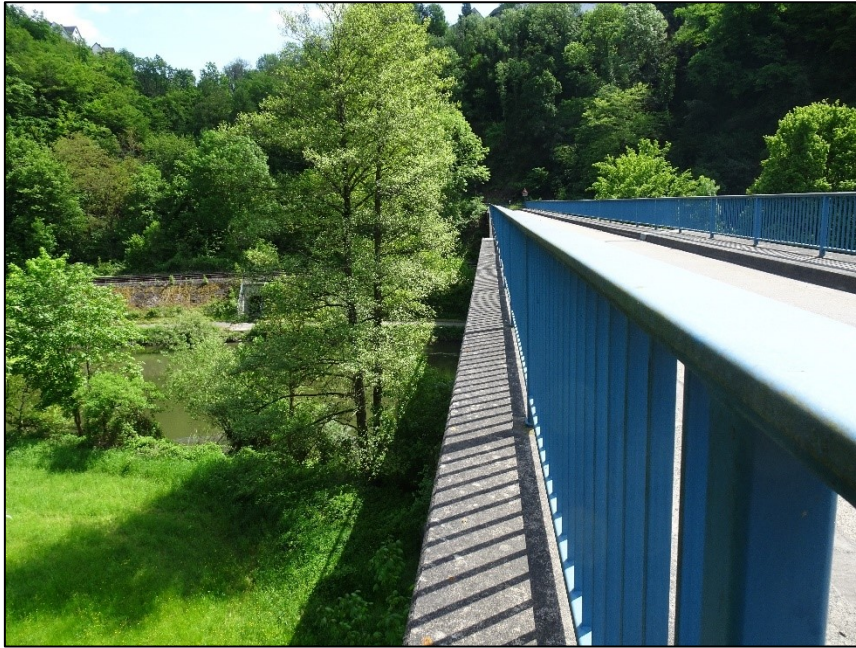
Abbildung 3: Baufeld am nordwestlichen Lahnufer, die Schwarzerle zählt nicht zum LRT 91E0*, da sie weit über der Wasserlinie wurzelt und hier kein geschlossener Ufergehölzsaum vorhanden ist.
