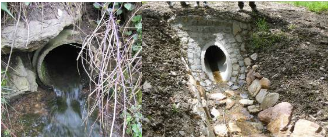
Abb. 14 und 15: Verrohrung DN 250 des Hahnbachs nördlich der B 275 im Sommer 2015 (links) und Verrohrung DN 300 des Hahnbaches im Sommer 2016 (rechts)
