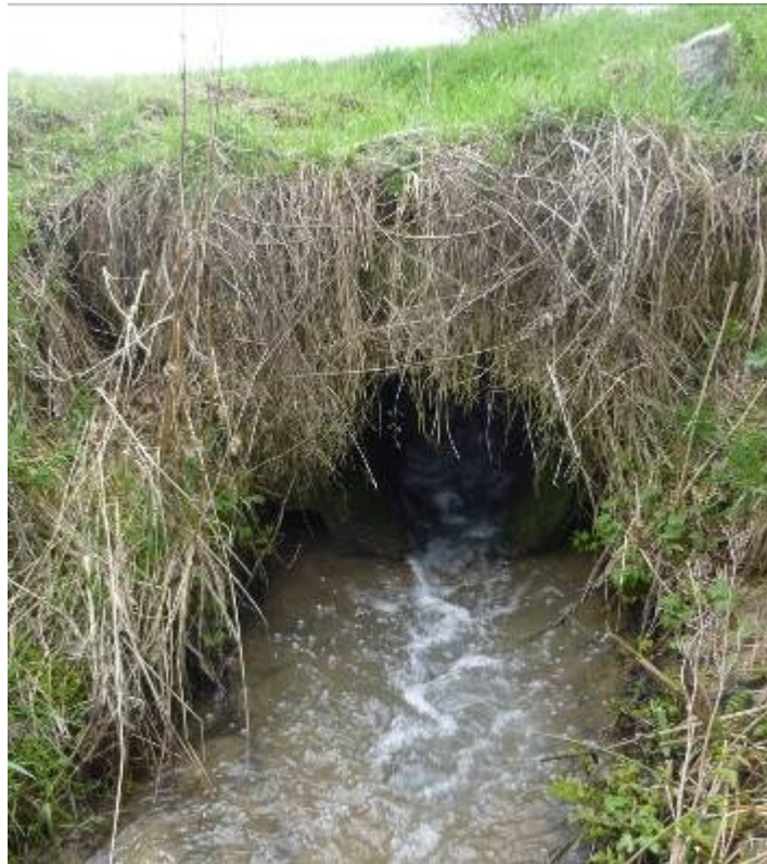
Abb. 13: Vorhandene Verrohrung DN 600 im Bereich des Wirtschaftsweges
