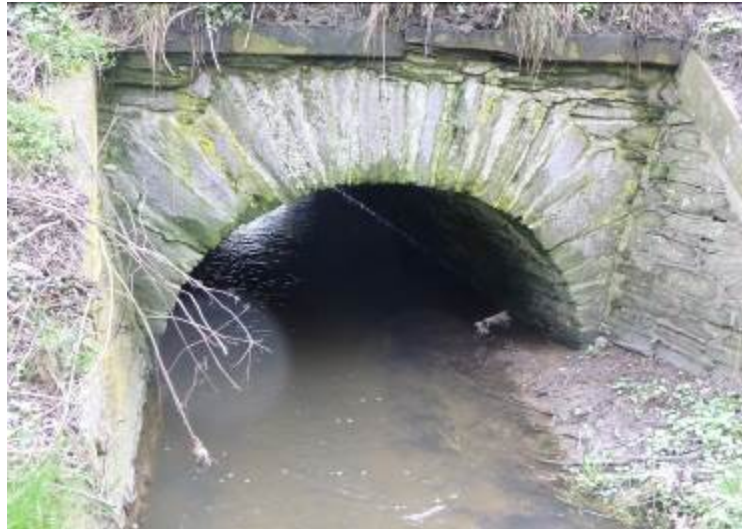
Abb. 13: Gemauerter Durchlass des Stockheimer Baches unter der B 275 im GESIS-Abschnitt 27
