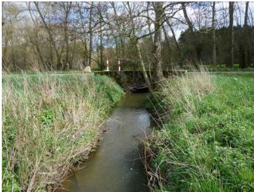
Abb. 11: Durchlass des Stockheimer Bachs unter einem Wirtschaftsweg unmittelbar vor Mündung in die Usa
