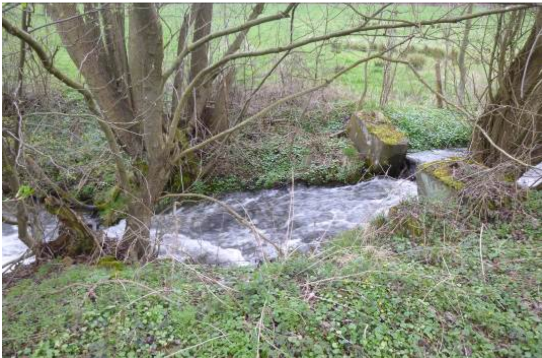
Abb. 11: Festes Wehr im GESIS-Abschnitt 26 mit Rampe und Absturz von insgesamt ca. 1,50 m
