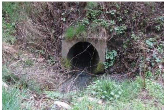
Abb. 16: Verrohrung DN 300 des Hahnbachs auf 50 m Länge unter B 275
