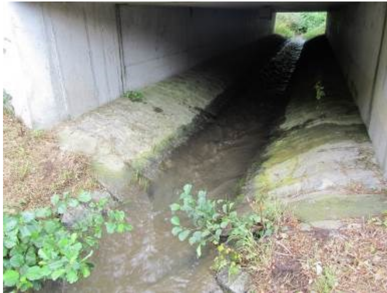
Abb. 11: Vorhandener Durchlass des Michelbachs unter der B 275 mit Massivsohle
