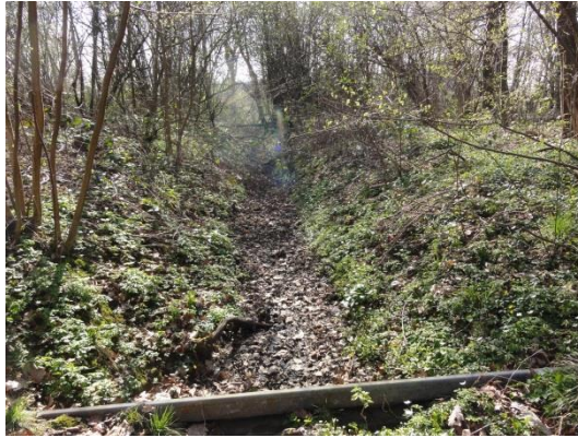
Abbildung 14: Naturnaher Graben im Wald, Blickrichtung Nordwesten
