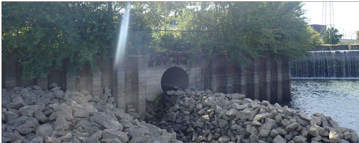
Abbildung 2: Mündung des Mörschgrabens über Durchlass in den Rhein
