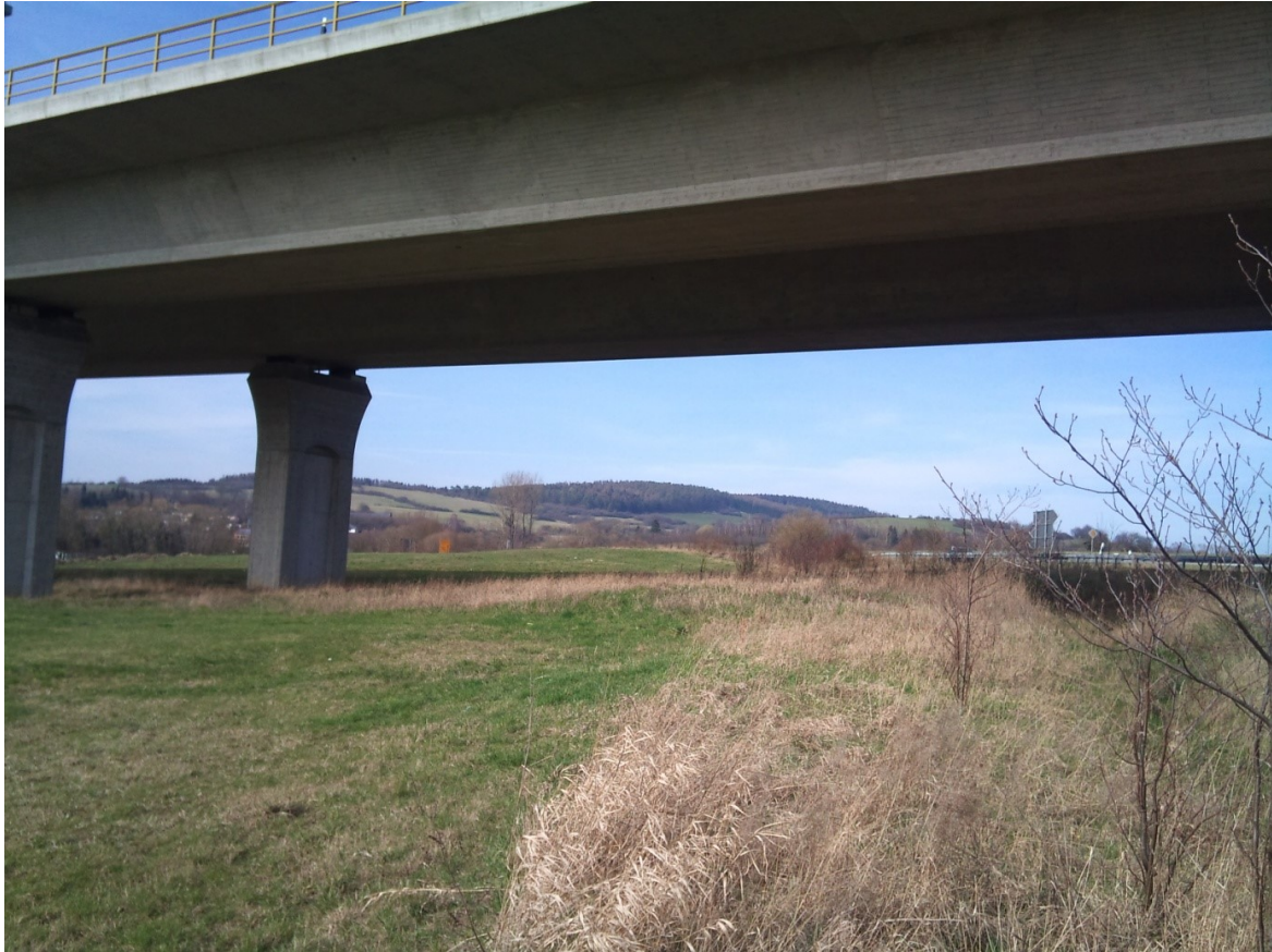
Abb. 8: Wehretalbrücke der A 44 (VKE 31) mit durchgehender krautiger Vegetation (Brückenfeld am östlichen Ende, lichte Höhe hier ca. 7 m)
