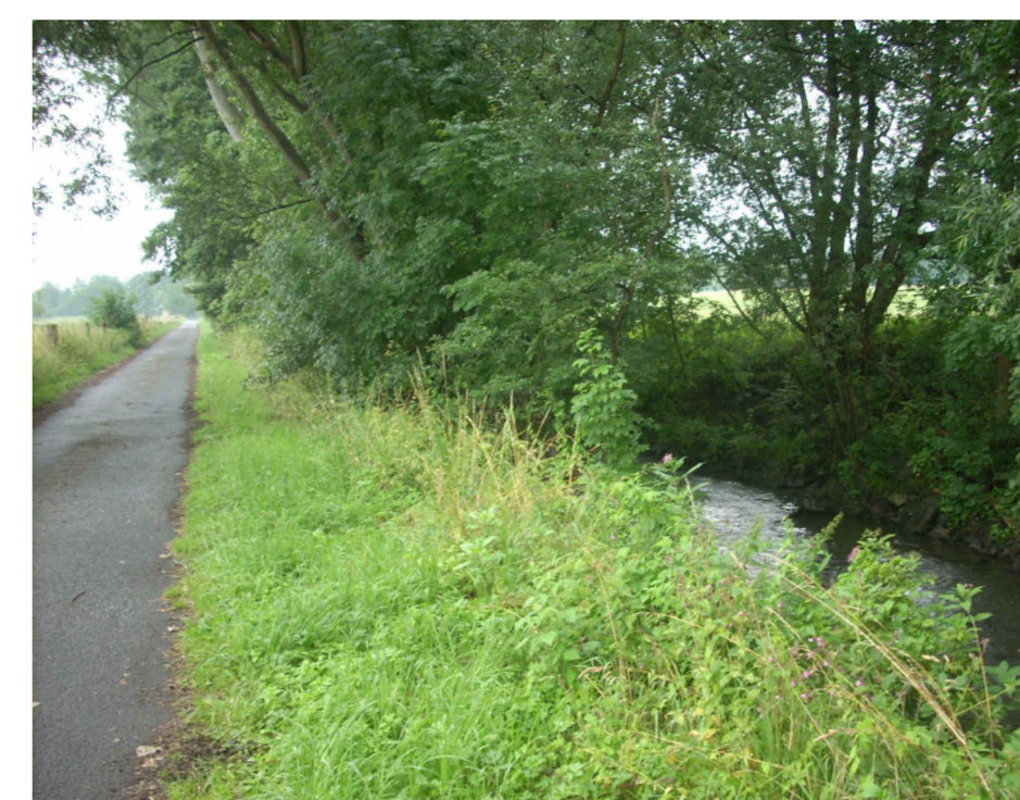
Abb. 3: Parallel zur Losse verläuft an der rechten Uferkante ein befestigter Weg (Losse Station km 6+530, gegen die Fließrichtung)
