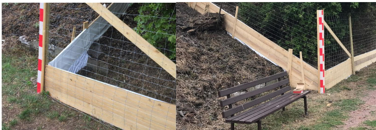
Abbildung 10 a & b: Beispiel eines kombinierten Reptilien- und Vegetationsschutzzauns (W.Kohn Landschaftsbau, EÜ Gartenstraße, Pommern). Die stabile Holzbauweise eignet sich vor allem für Vorhaben mit längeren Bauzeiten. Die Ausführung ist deutlich wetterfester und wartungsärmer als herkömmliche Folienzäune.
