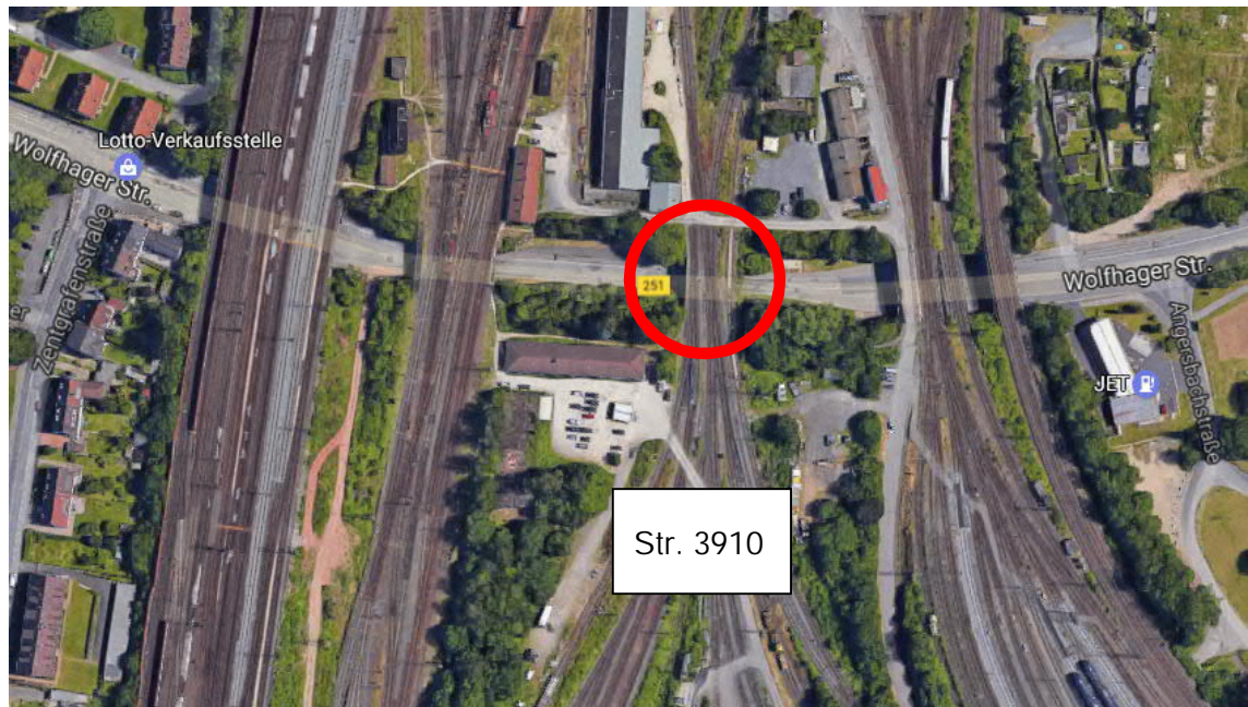
Abbildung 2: Luftbild EÜ km 0,430 Strecke 3910 (Quelle: google earth)
