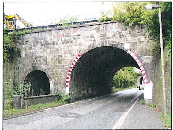
Abbildung 5: EÜ der Strecke 3910, Ostseite [22]
