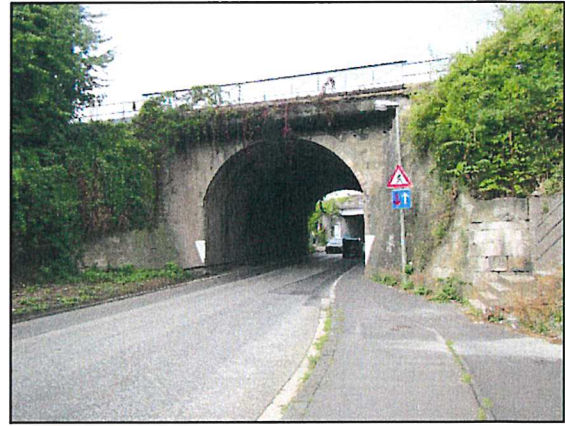
Abbildung 3: EÜ der Strecke 3912, Ostseite [22]
