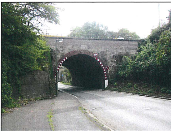
Abbildung 4 EÜ der Strecke 3910, Westseite [22]
