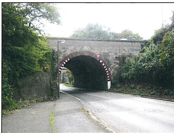
Abbildung 4 EÜ der Strecke 3910, Westseite [20]
