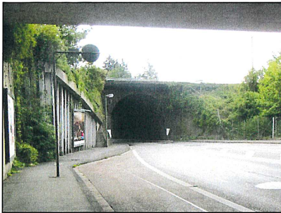
Abbildung 2 EÜ der Strecke 3912, Westseite [20]
