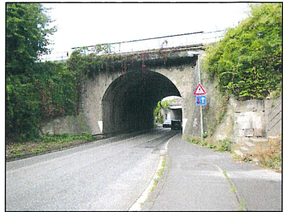
Abbildung 3: EÜ der Strecke 3912, Ostseite [20]
