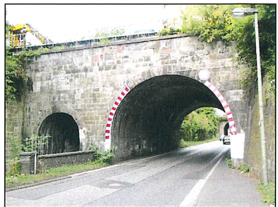
Abbildung 5: EÜ der Strecke 3910, Ostseite [20]
